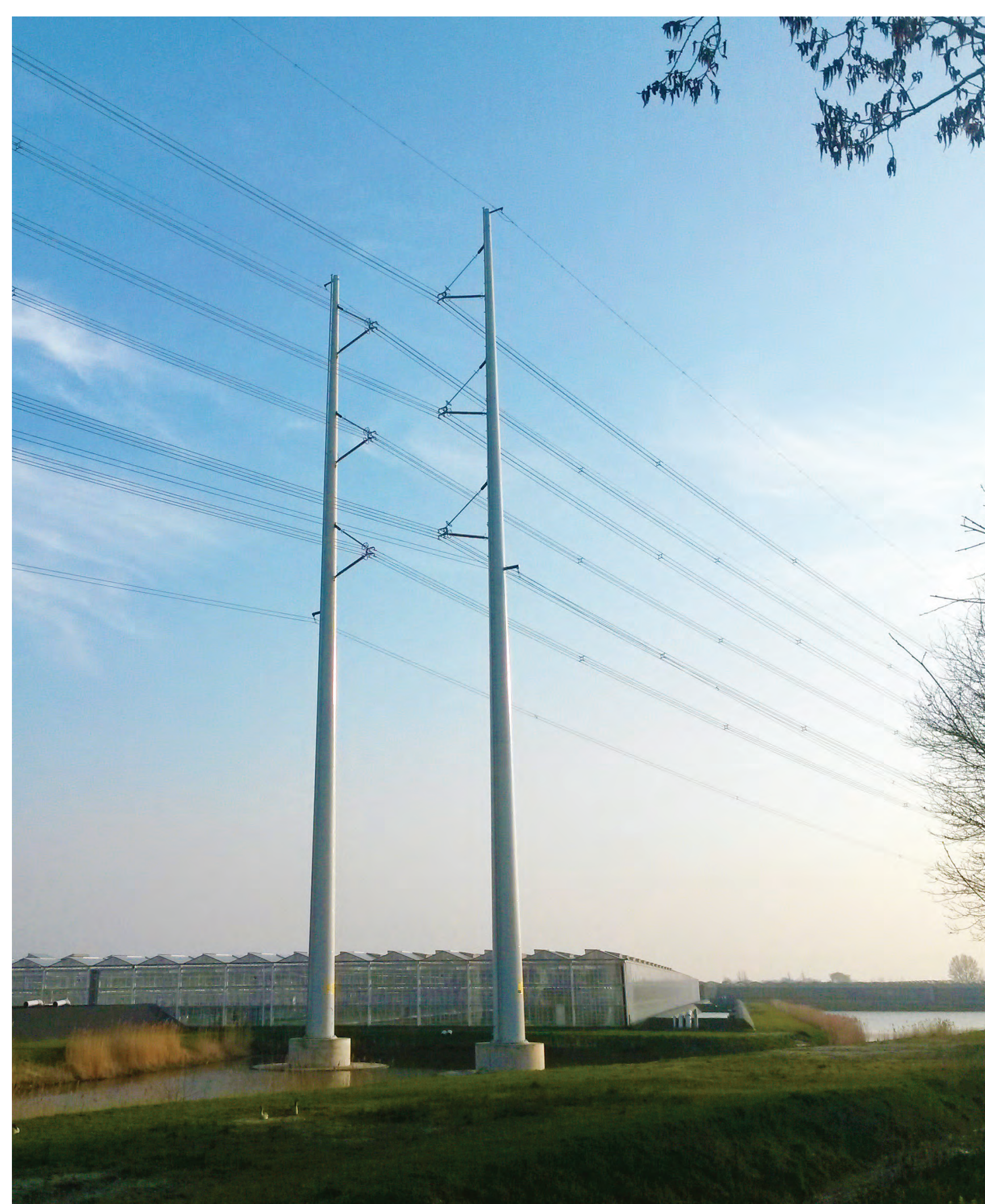
Quelle: Bundesverband Kompaktleitung
