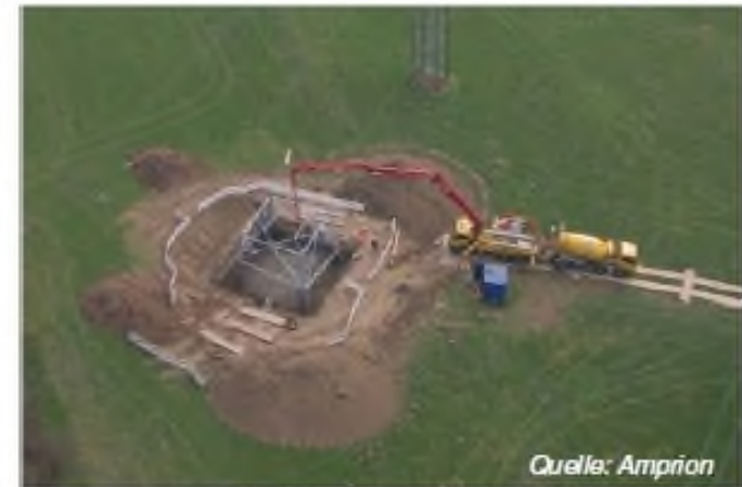
Betonieren der Fundamentplatte eines Plattenfundamentes
