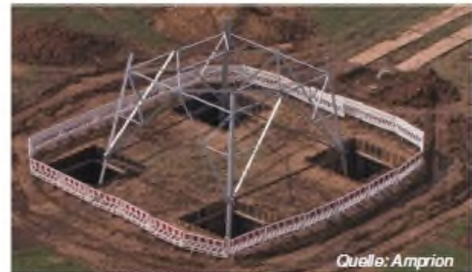
Gründung eines Stufenfundamentes
