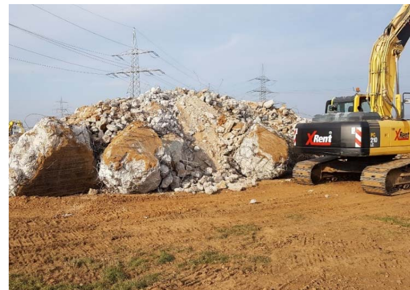
Beseitigung eines Bunkers an der Konverterbaustelle
