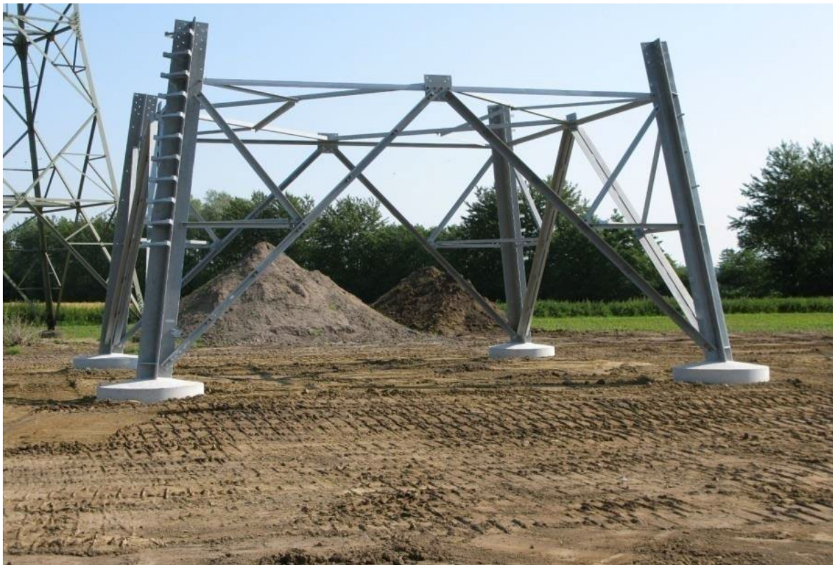
Abbildung 21: Montierter Mastfuß (Quelle: Amprion GmbH)
