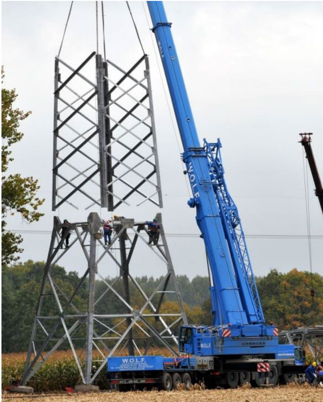
Abbildung 22: Mastmontage (Stocken) (Quelle: Amprion GmbH)
