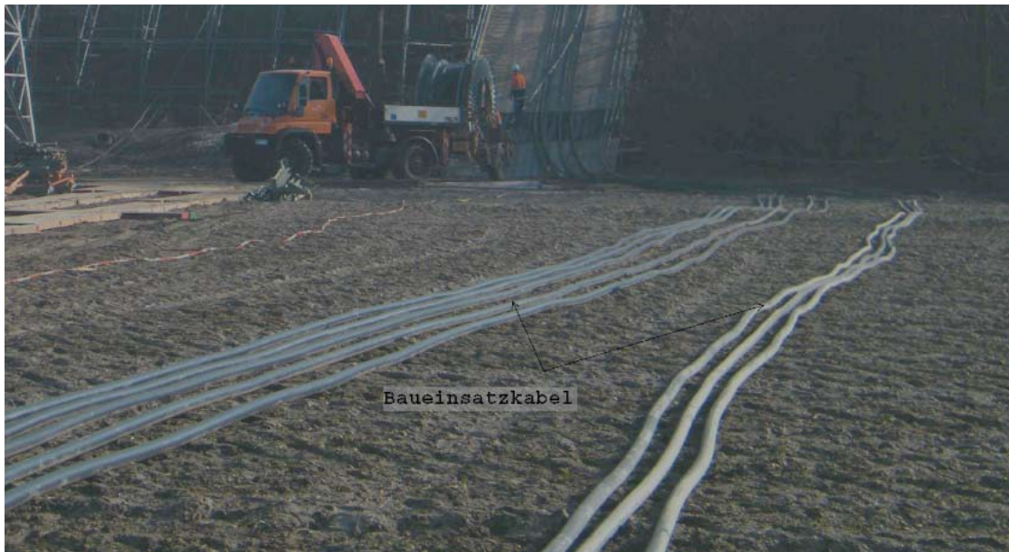
Abbildung 28: Verlegung von Baueinsatzkabel als Provisorium für 110-kV-Leitungen (Quelle Amprion)
