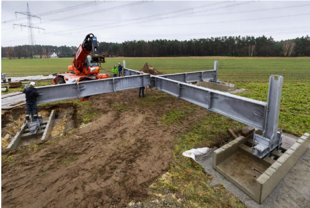
Abbildung 6: Freileitungsprovisorium, Einsetzen der Querträger (Quelle Amprion)
