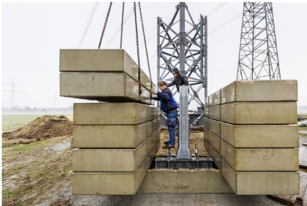
Abbildung 7: Freileitungsprovisorium, Ablegen der Auflastgewichte (Quelle Amprion)
