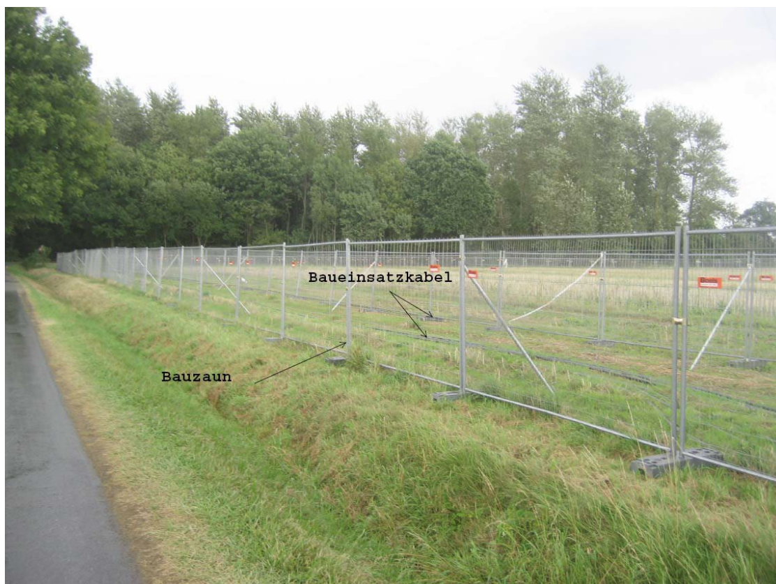
Abbildung 27: Baueinsatzkabel für 110-kV-Leitungen mit Sicherheitszaun (Quelle Amprion)
