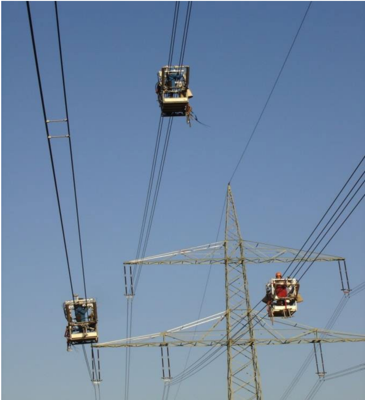
Abbildung 26: Montage der Feldbündelabstandhalter mit Fahrwagen (Quelle: Amprion GmbH)
