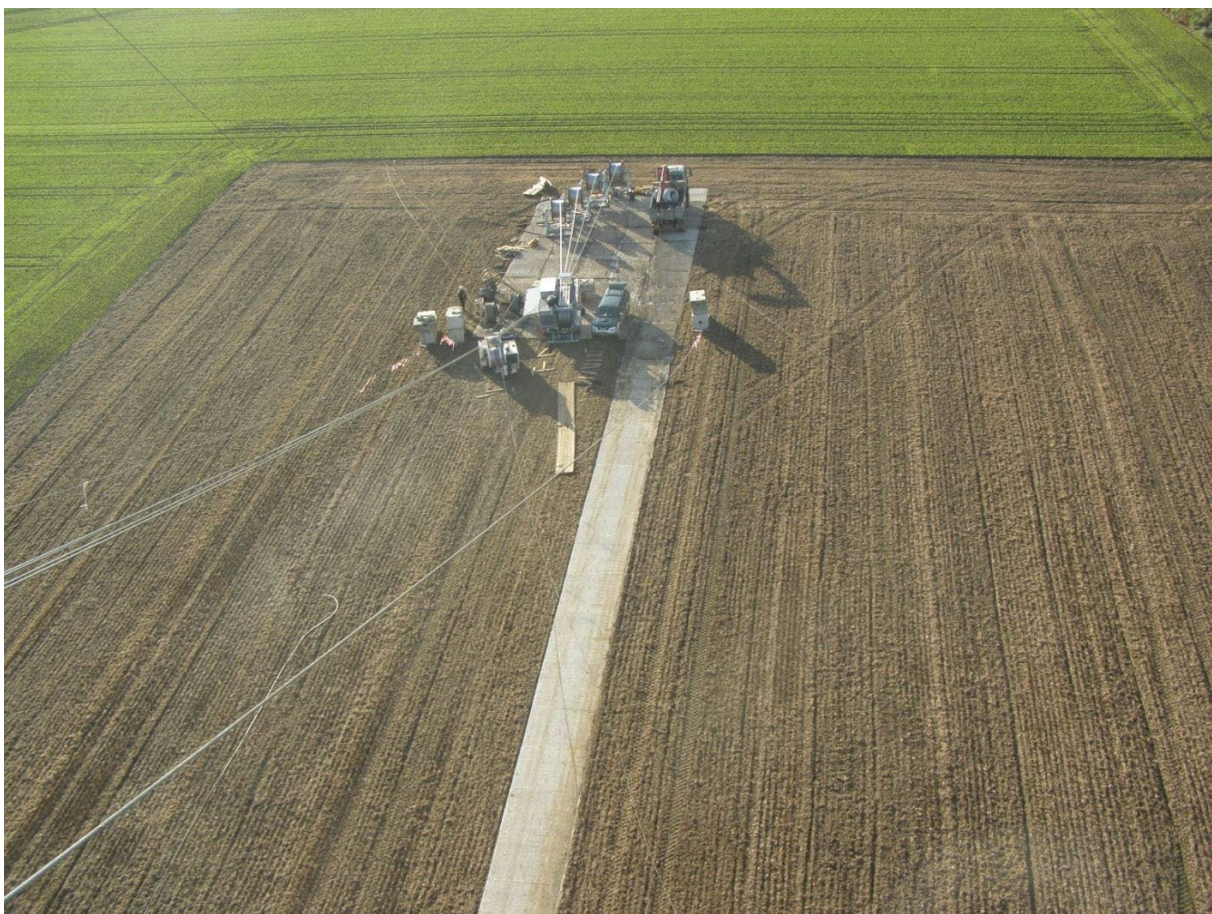
Abbildung 25: Windenplatz eines Viererbündel-Seilzuges (Quelle: Amprion GmbH)
