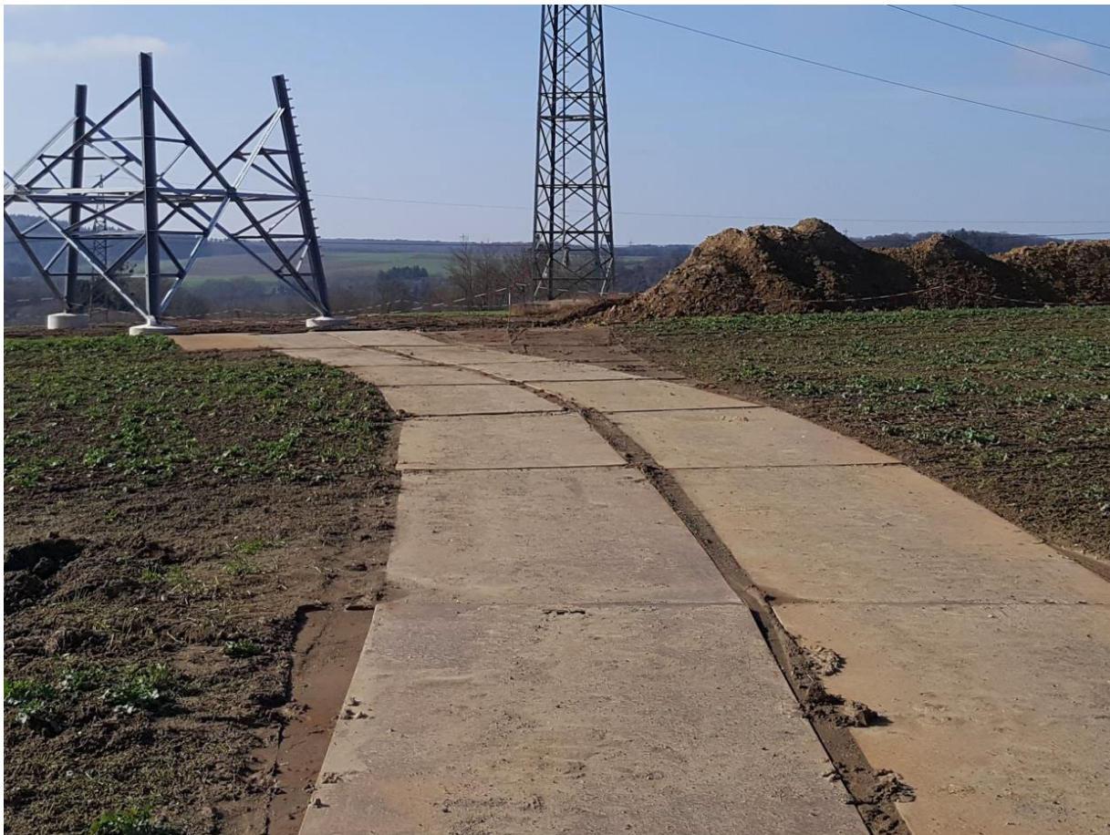
Abbildung 16: Temporäre Zuwegung über Fahrplatten (Quelle: Amprion GmbH)
