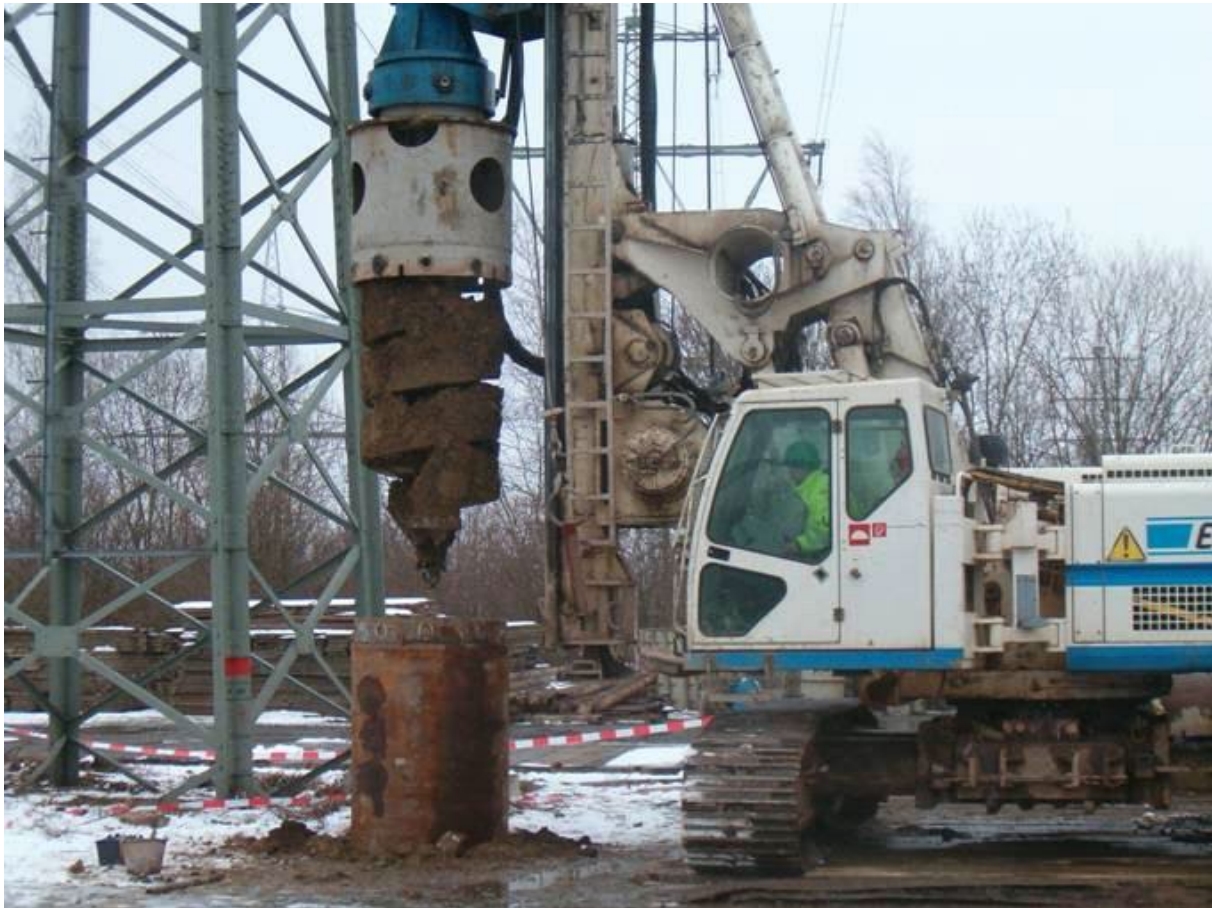
Abbildung 20: Bohrung für einen Bohrpfahl (Quelle: Amprion GmbH)
