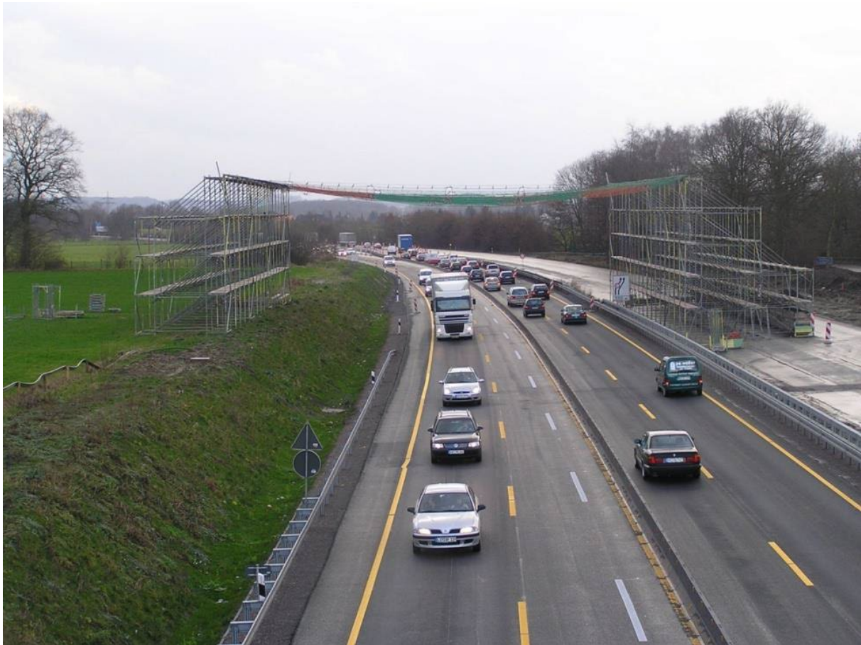
Abbildung 24: Stahlrohrschutzkonstruktion mit Netz über einer Autobahn (Quelle: Amprion GmbH)
