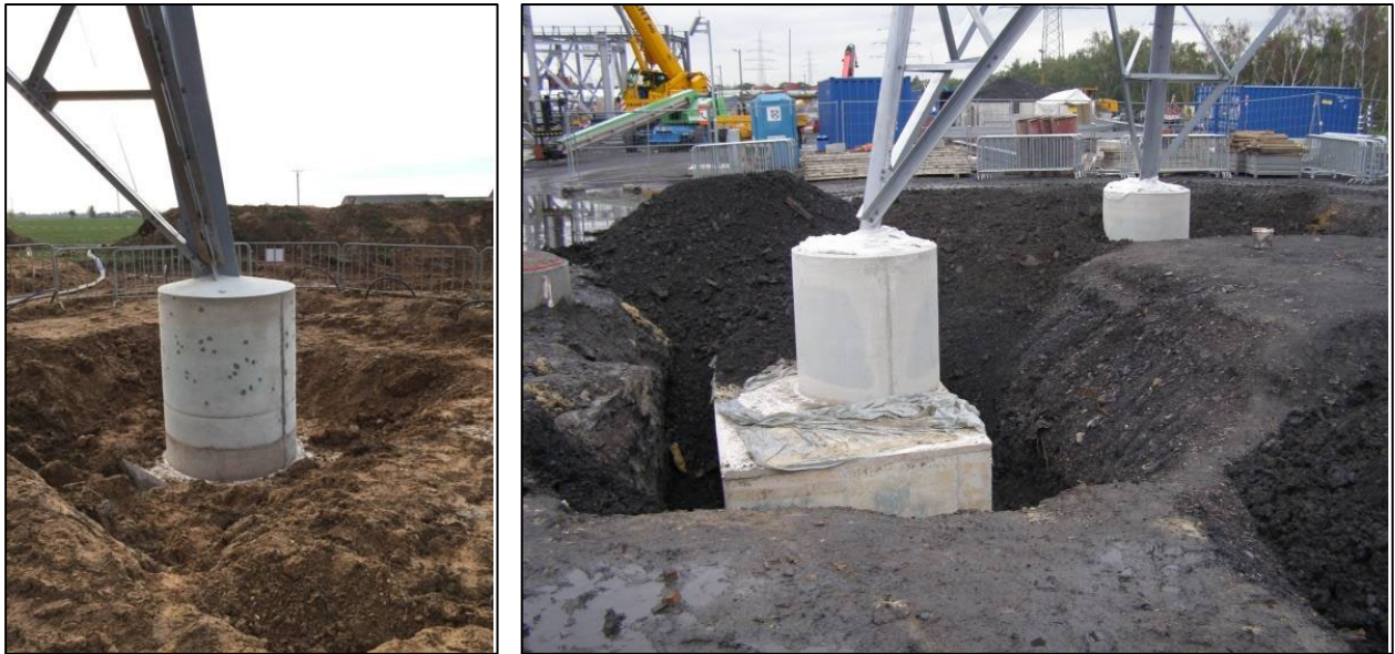
Abbildung 4: Freigelegtes Betonfundament eines Eckstiels
