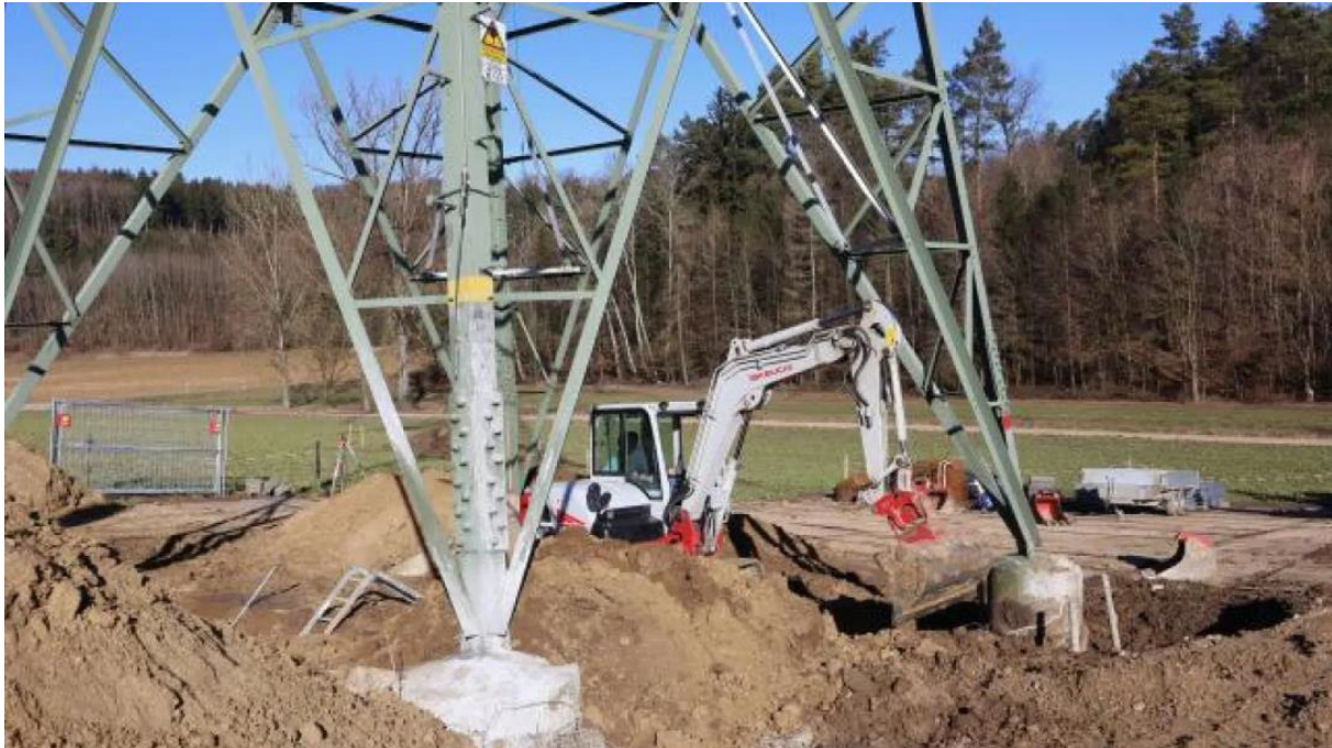
Abbildung 2: Freilegen der Bohrfahlfundamente (Bsp.: Zwillingsbohrpfahl)
