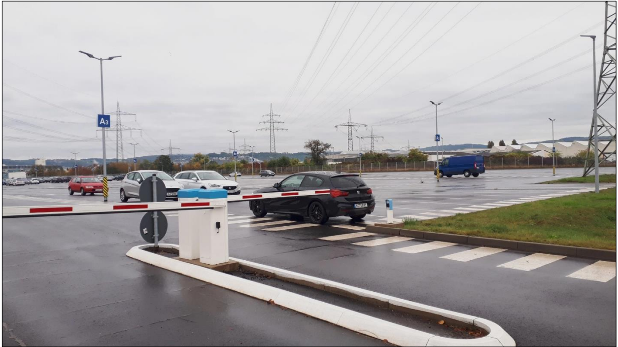
Foto 59: Der Ostteil der Trasse verläuft durch ein dicht bebautes und stark versiegeltes Gewerbe- und Industriegebiet (465)
