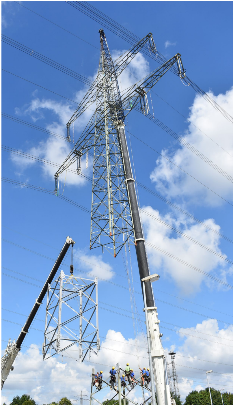
Abbildung 19: Mastmontage (Einbau Zwischenschuss) (Quelle: Amprion GmbH)
