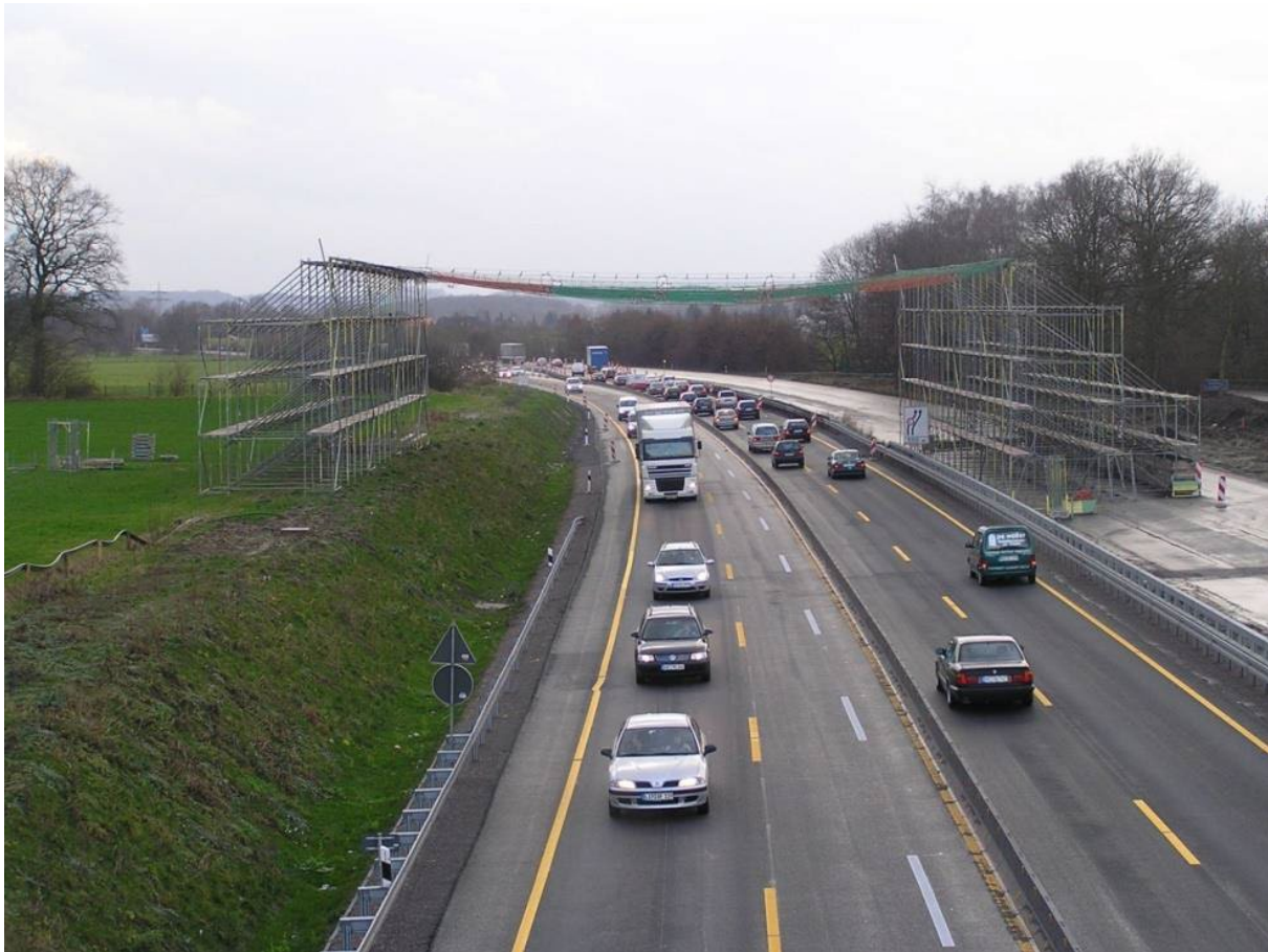
Abbildung 21: Stahlrohrschutzkonstruktion mit Netz über einer Autobahn (Quelle: Amprion GmbH)
