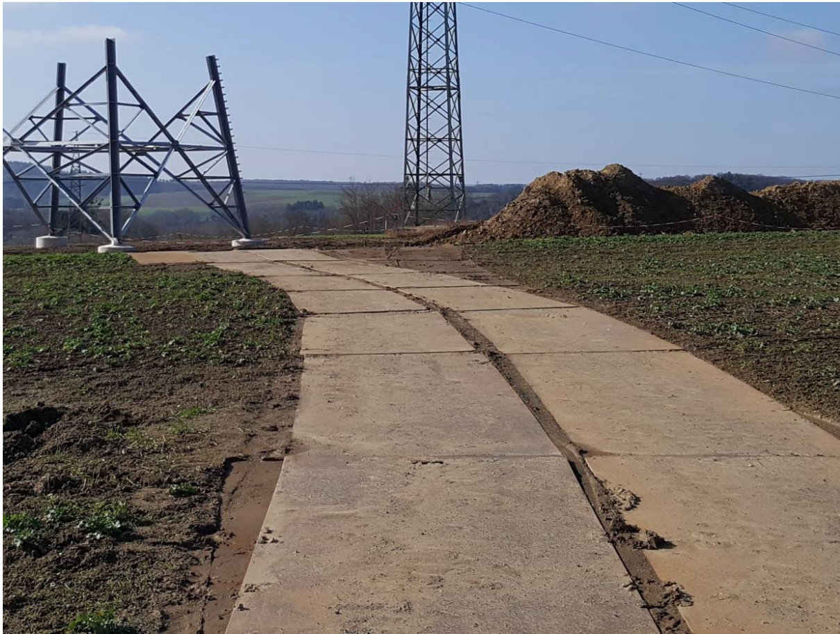
Abbildung 13: Temporäre Zuwegung über Fahrplatten (Quelle: Amprion GmbH)
