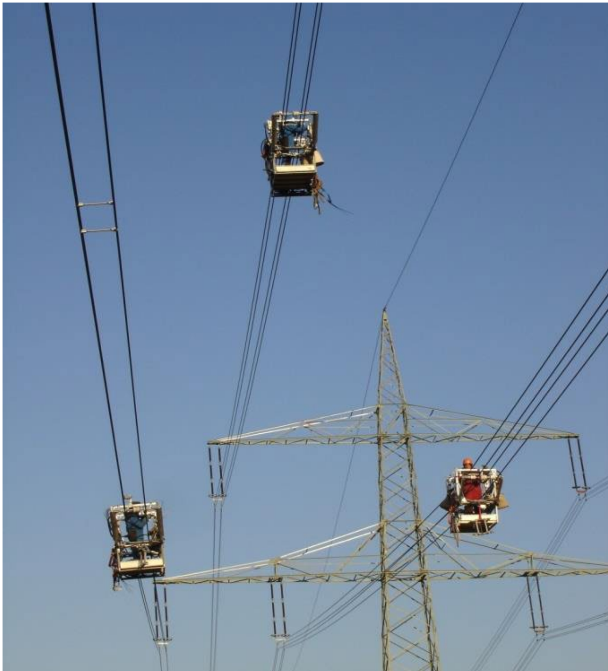
Abbildung 23: Montage der Feldbündelabstandhalter mit Fahrwagen (Quelle: Amprion GmbH)
