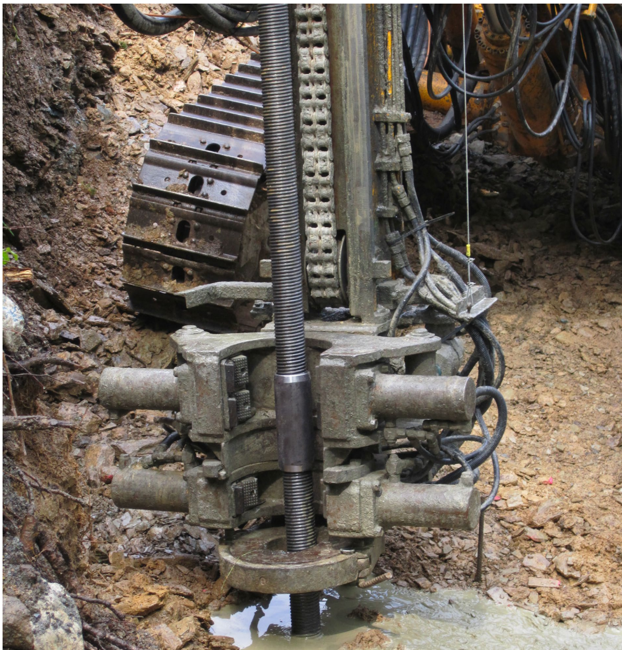
Abbildung 17: Einbringung Kleinverpresspfahl (Quelle: Amprion GmbH)
