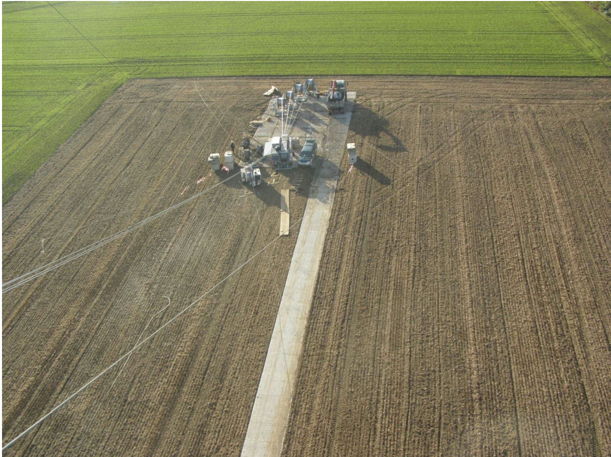
Abbildung 22: Windenplatz eines Viererbündel-Seilzuges (Quelle: Amprion GmbH)
