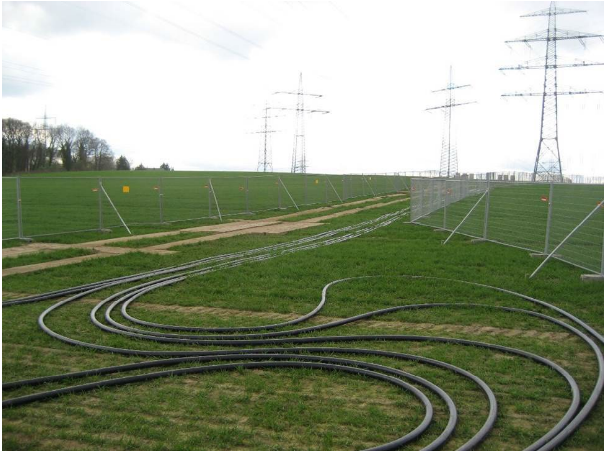
Abbildung 24: Darstellung Baueinsatzkabel (Quelle Amprion)
