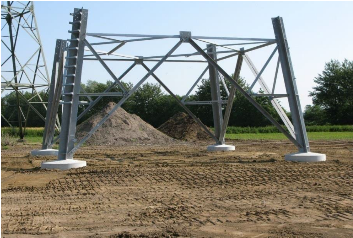
Abbildung 18: Mastfuß mit sichtbarem Fundamentkopf (Quelle: Amprion GmbH)
