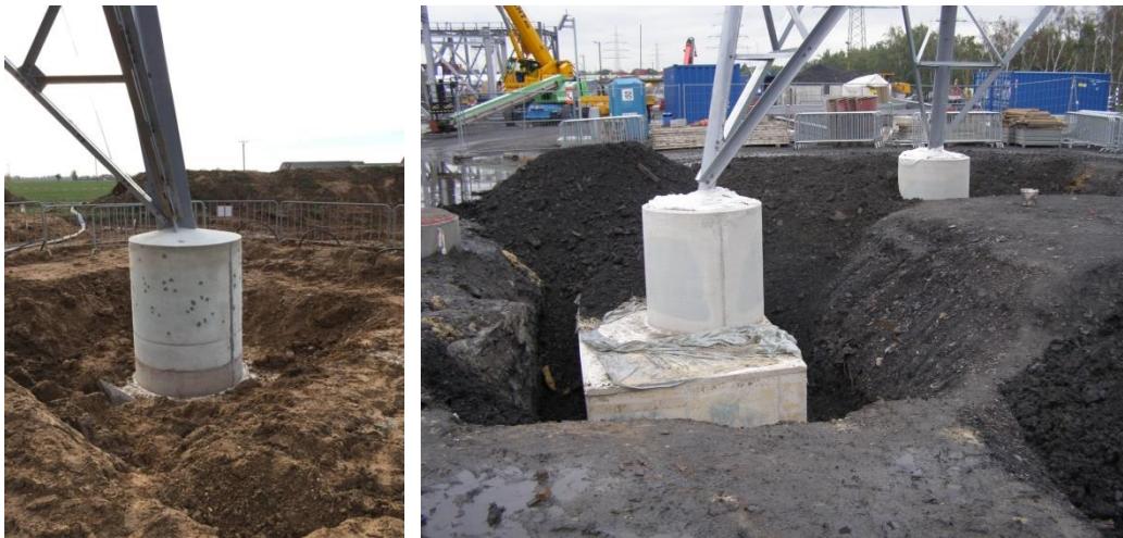
Abbildung 4: Freigelegtes Betonfundament eines Eckstiels
