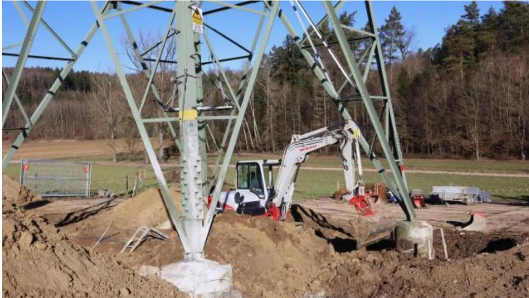
Abbildung 2: Freilegen der Bohrpfahlfundamente (Bsp.: Zwillingsbohrpfahl)
