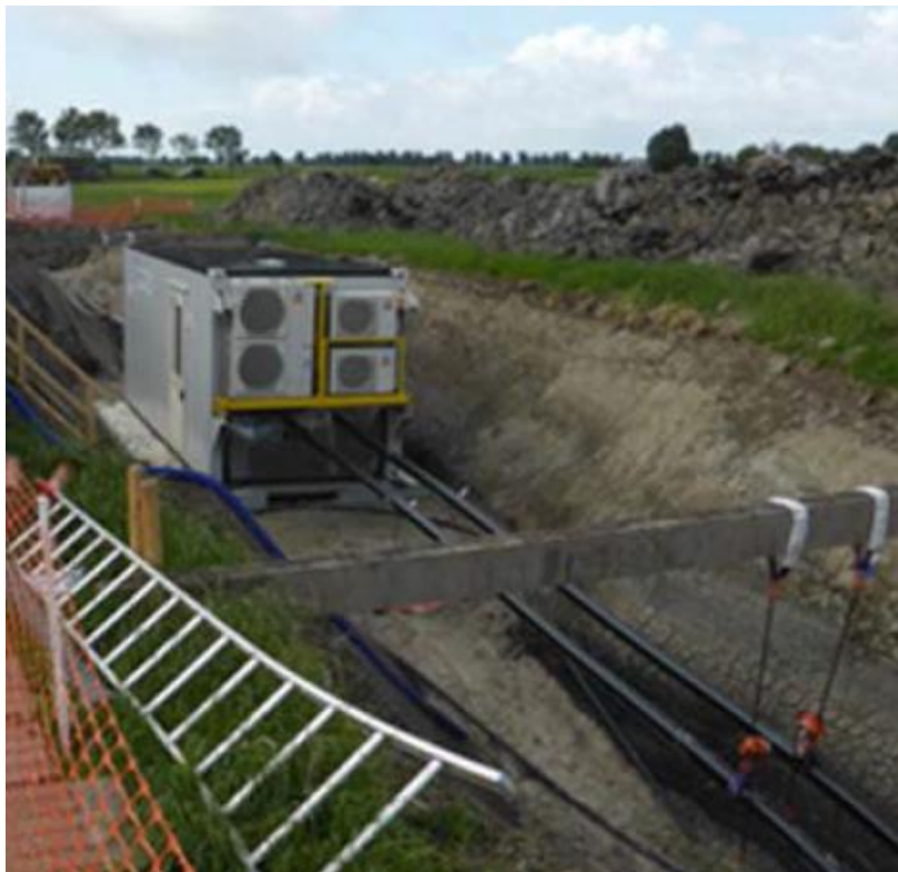
Abbildung 11: Temporärer Muffen-Container
