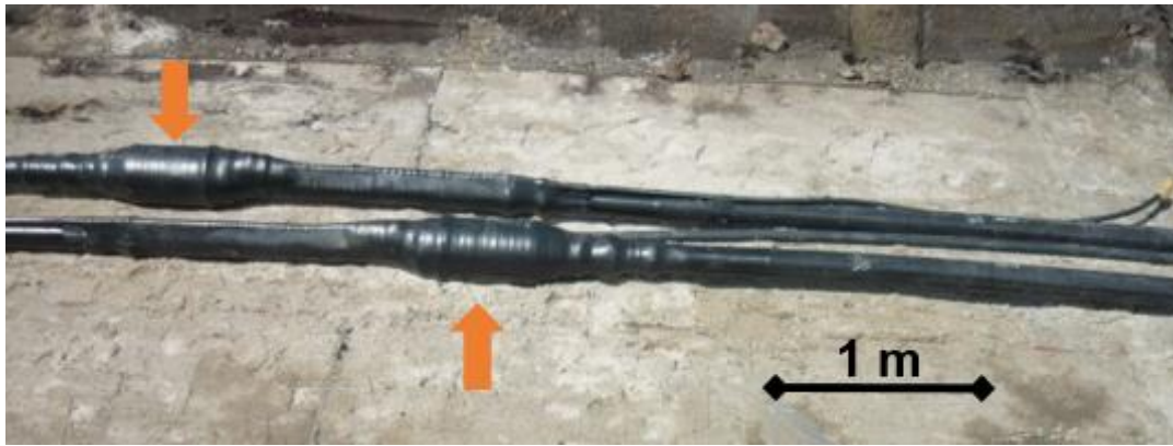
Abbildung 12: Muffen (Pfeilmarkierung) vor Wiederverfüllung des Leitungsgrabens
