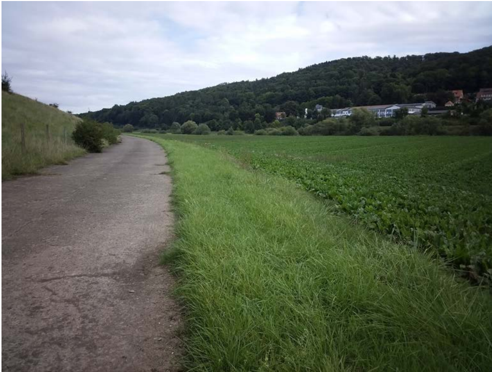
Abbildung 5 Blick vom Fahrweg nach Norden, im südlichen Bereich des Unterbeckens. Links der Damm des Beckens.
