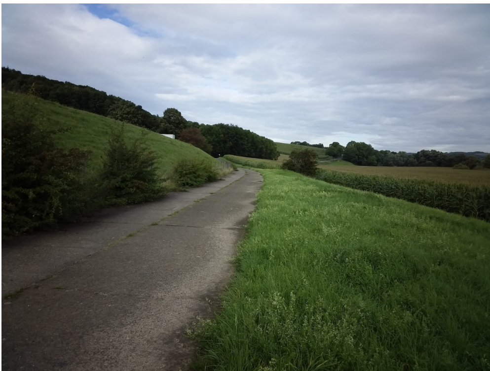
Abbildung 6 Blick vom Fahrweg nach Norden im nördlichen Bereich. Links auf dem Damm ist das Pumpwerk erkennbar.
