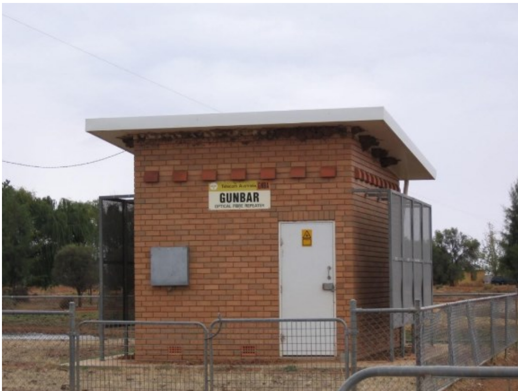
Abbildung 1: Beispiel einer Lichtwellenleiter-Zwischenstation 1
