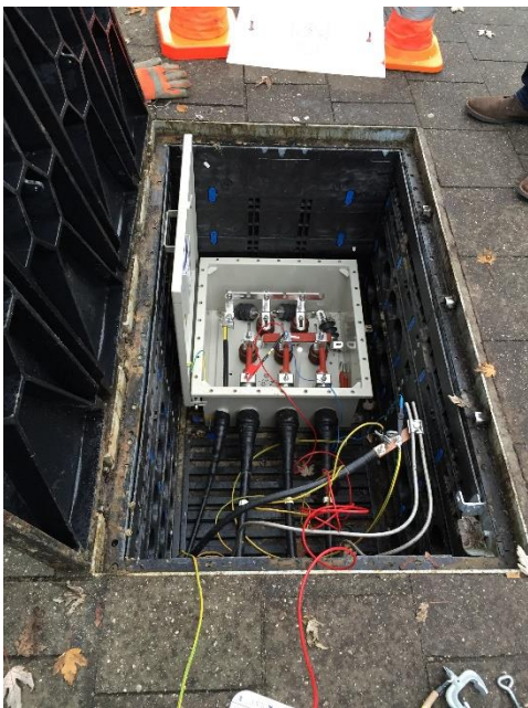
Abbildung 13: Mögliches Design der Linkbox
