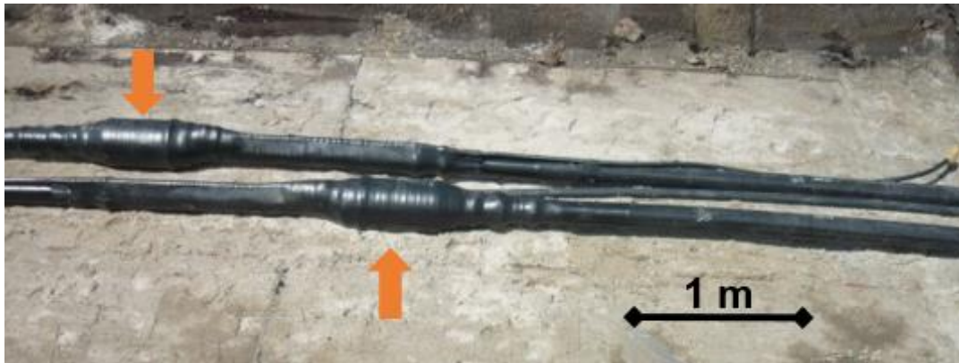
Abbildung 12: Muffen (Pfeilmarkierung) vor Wiederverfüllung des Leitungsgrabens
