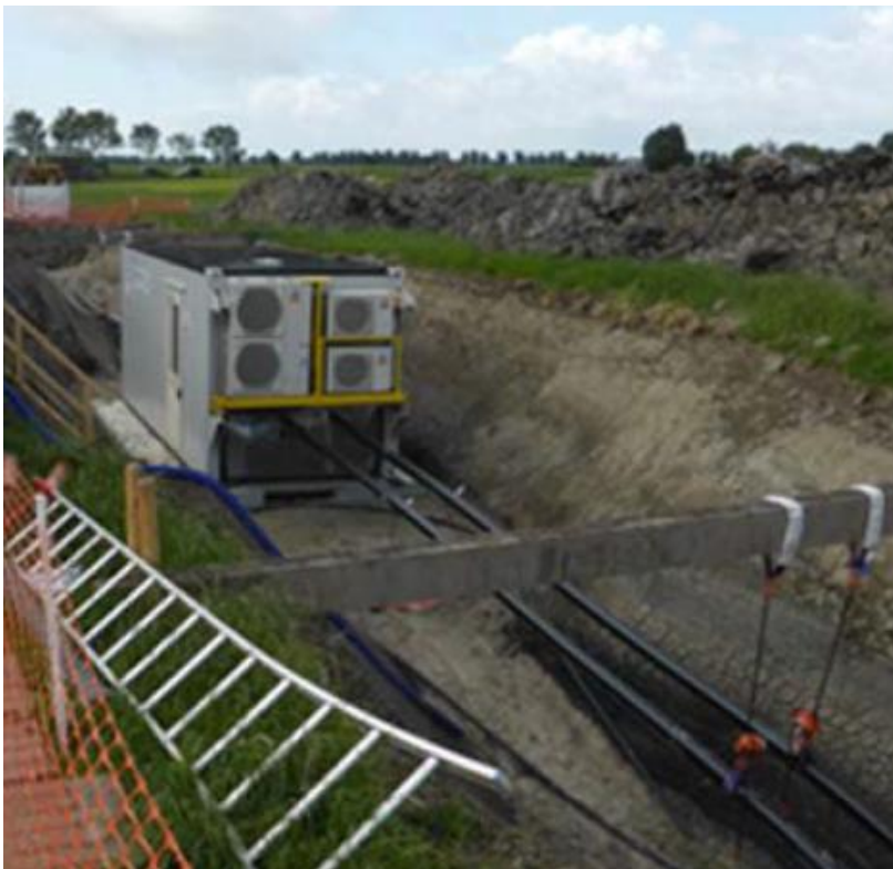
Abbildung 11: Temporärer Muffen-Container
