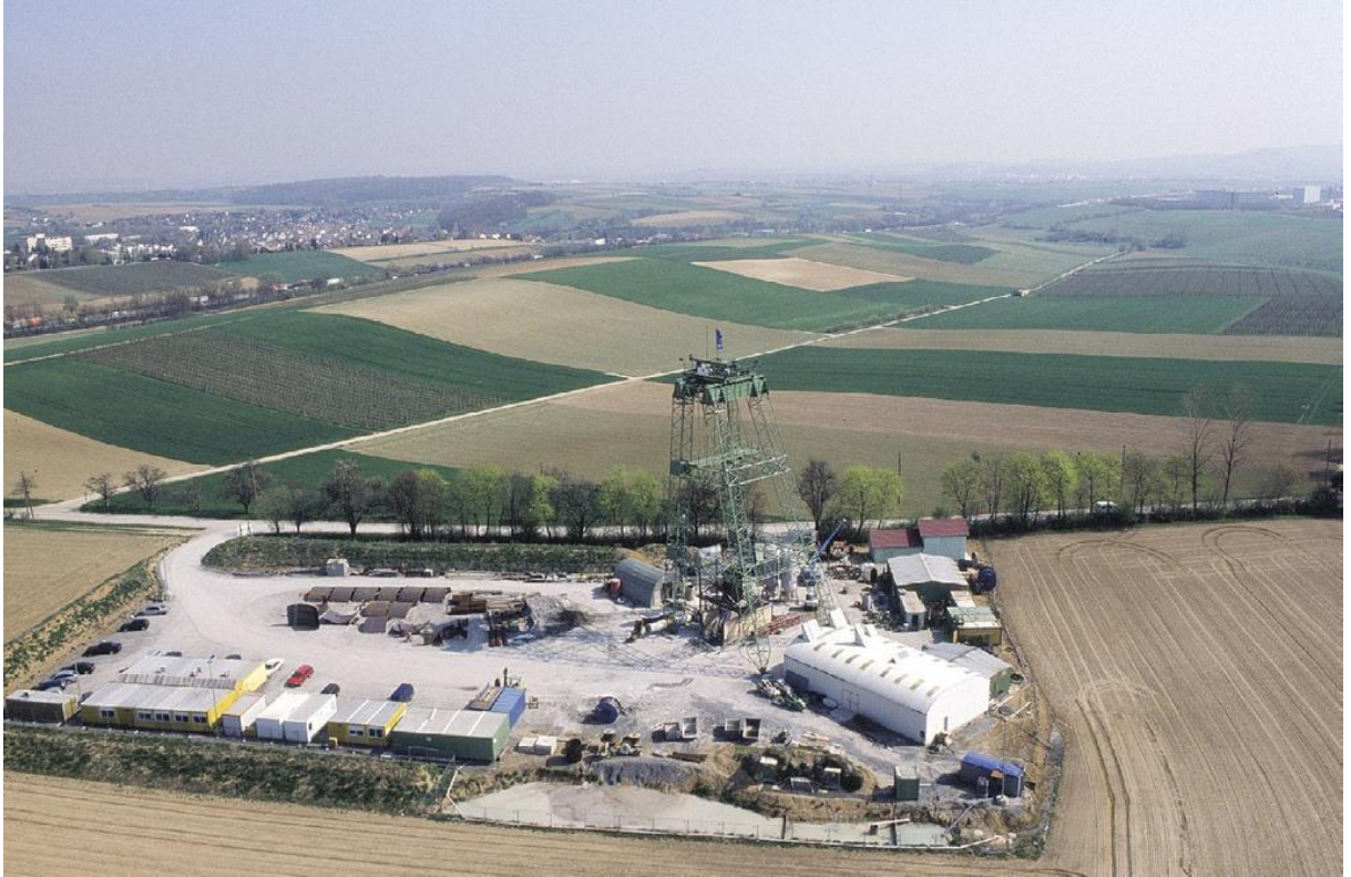
Abbildung 23: Abteufen von Schacht Konradsberg (2003 bis 2004)
