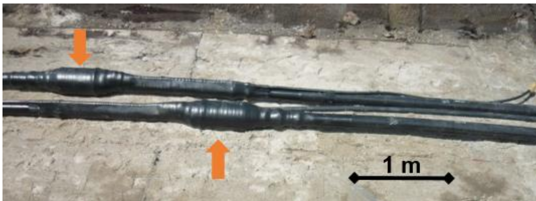
Abbildung 15: Muffen (Pfeilmarkierung) vor Wiederverfüllung des Leitungsgrabens
