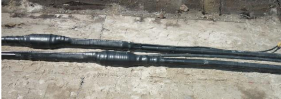
Abbildung 5: Fertige Muffen vor dem Verfüllen mit Bettungsmaterial
