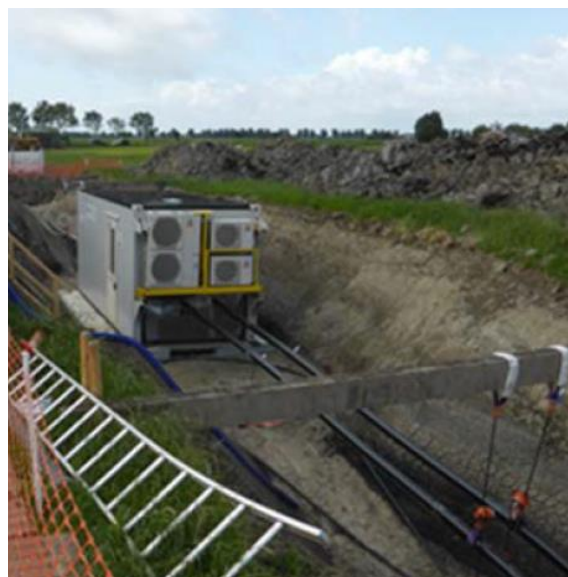
Abbildung 4: Temporärer Muffen-Container
