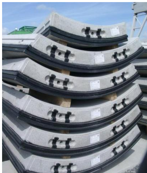
Abbildung 29: Sechs Tübbingsegmente zur Bildung eines Tunnelrings (Querung der Ems bei Emden)
