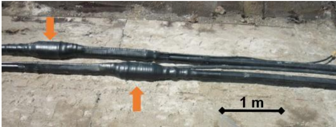
Abbildung 12: Muffen (Pfeilmarkierung) vor Wiederverfüllung des Leitungsgrabens
