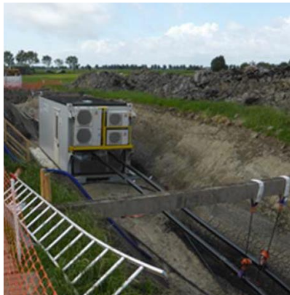
Abbildung 11: Temporärer Muffen-Container
