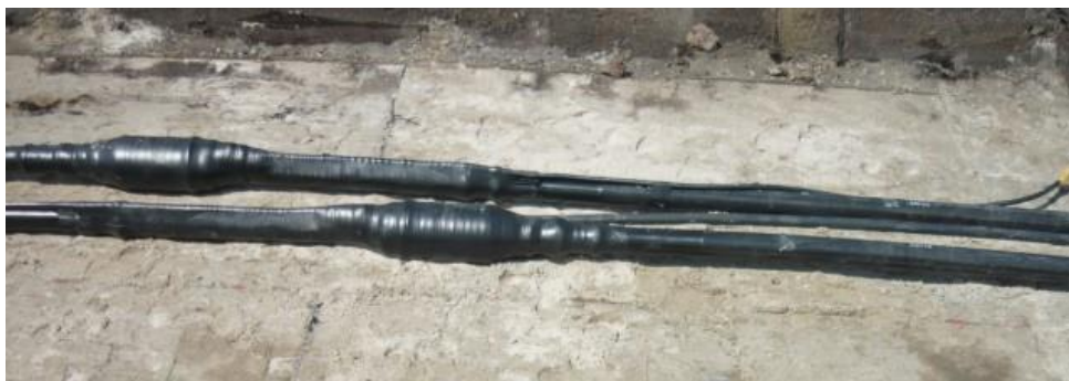
Abbildung 12: Fertige Muffen vor dem Verfüllen mit Bettungsmaterial
