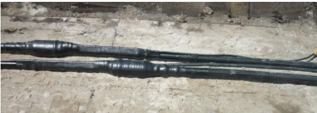
Abbildung 5: Fertige Muffen vor dem Verfüllen mit Bettungsmaterial
