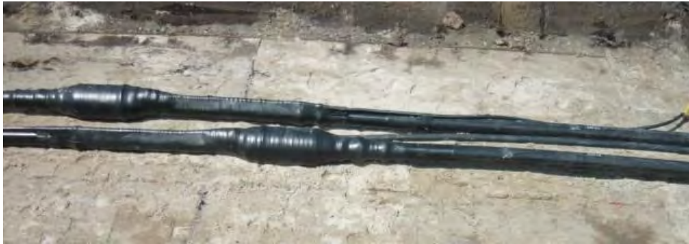
Abbildung 12: Fertige Muffen vor dem Verfüllen mit Bettungsmaterial
