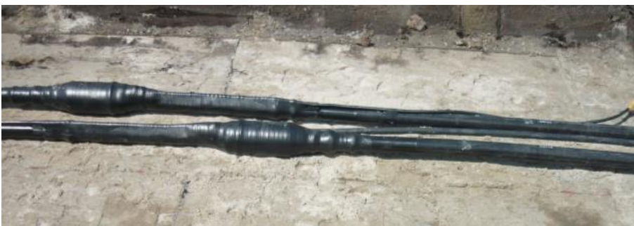
Abbildung 5: Fertige Muffen vor dem Verfüllen mit Bettungsmaterial
