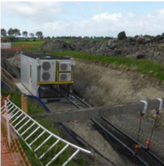
Abbildung 4: Temporärer Muffen-Container
