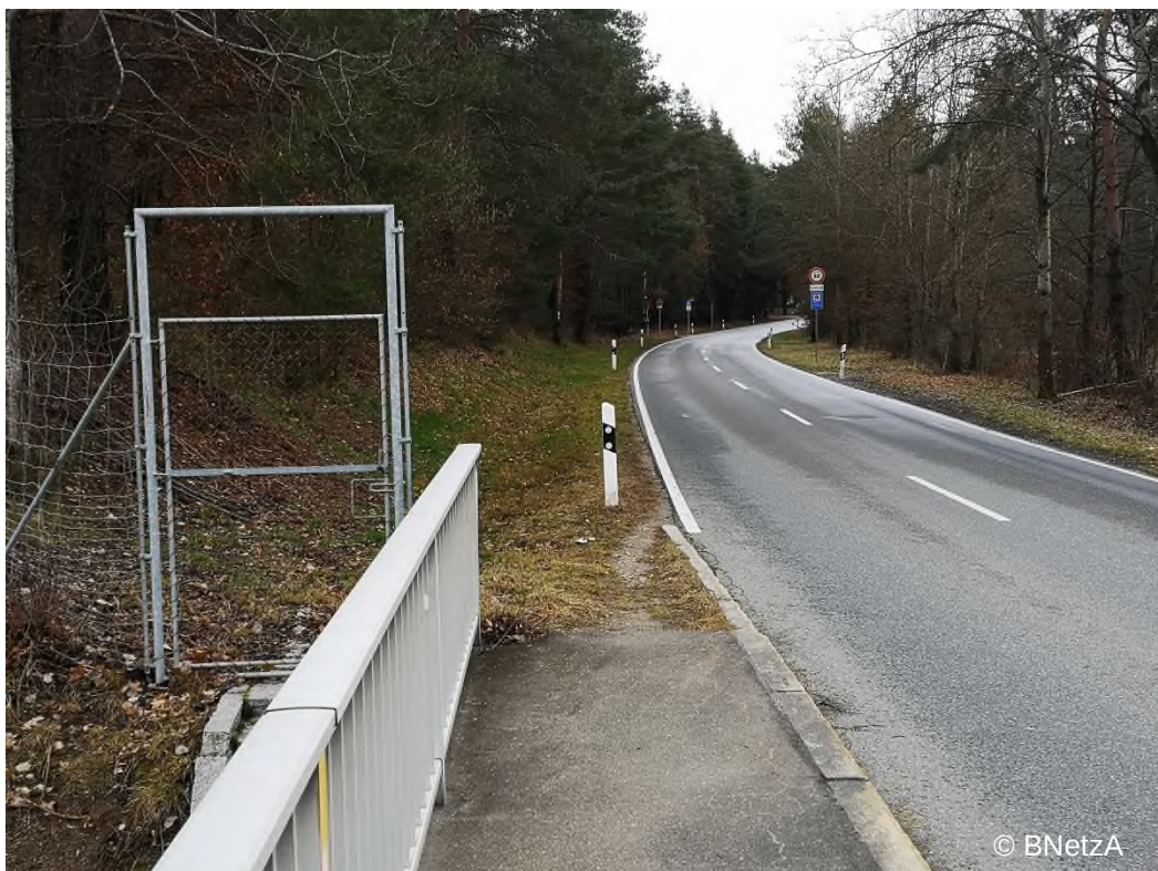
Aufnahme von einer Überführung der Autobahn. Unmittelbar dahinter beginnt das WSG.
