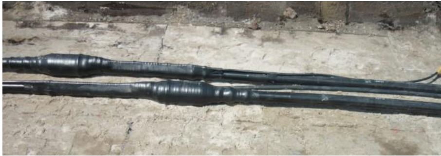
Abb. 7: Fertige Muffen vor dem Verfüllen mit Bettungsmaterial
