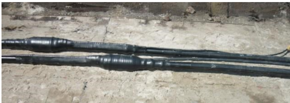
Abbildung 12: Fertige Muffen vor dem Verfüllen mit Bettungsmaterial
