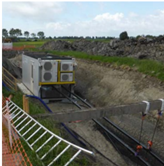
Abbildung 11: Temporärer Muffen-Container
