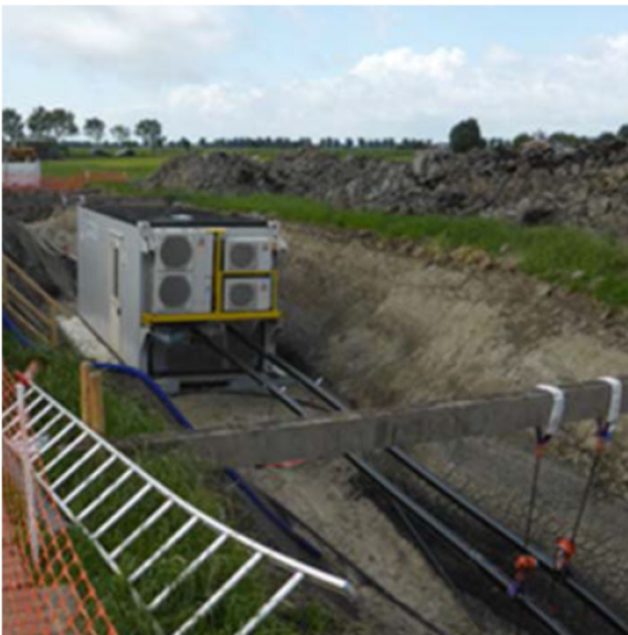
Abbildung 4: Temporärer Muffen-Container
