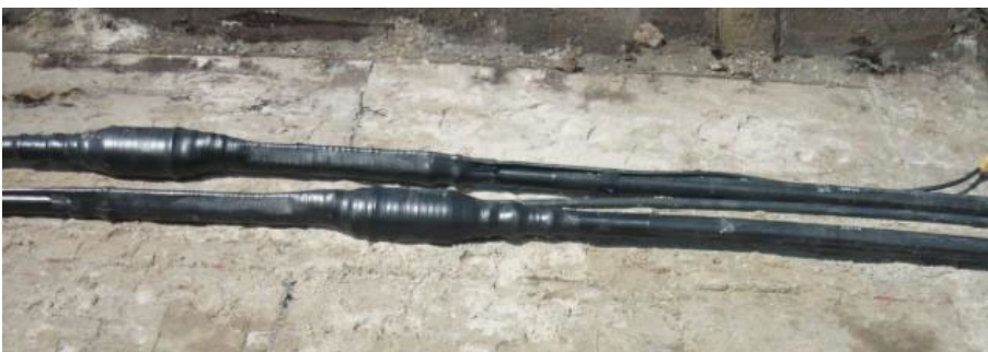
Abbildung 5: Fertige Muffen vor dem Verfüllen mit Bettungsmaterial
