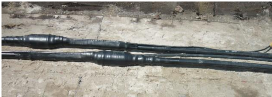
Abb. 7: Fertige Muffen vor dem Verfüllen mit Bettungsmaterial
