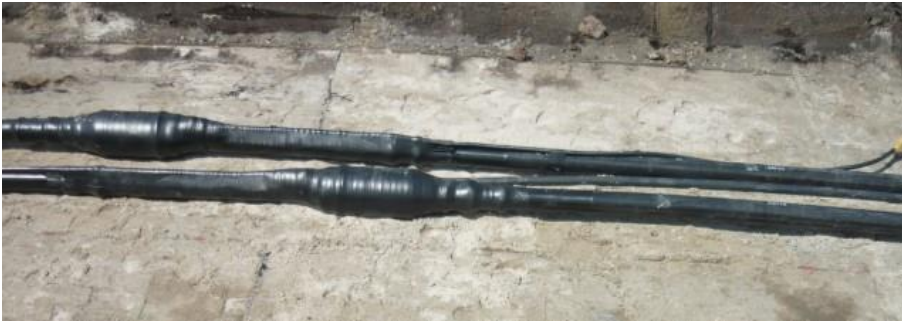
Abb. 7: Fertige Muffen vor dem Verfüllen mit Bettungsmaterial
