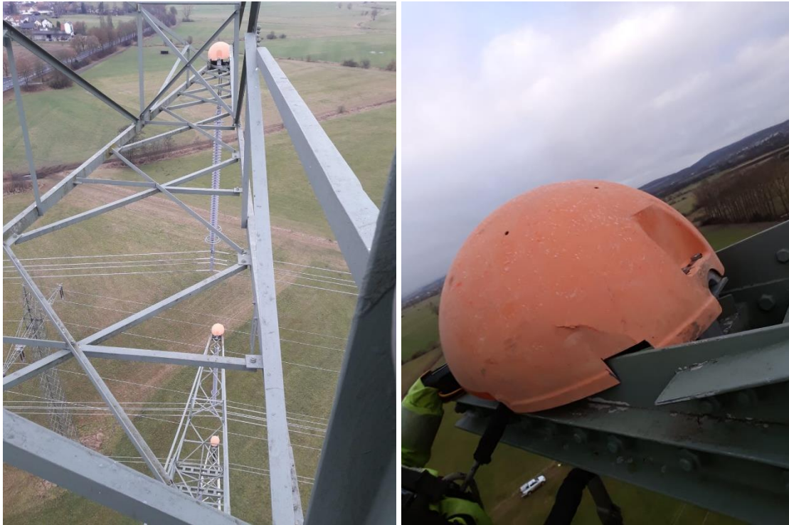
Abb. 1: Eingebaute Luftwarnkugeln zur Vermeidung von Brutansiedlungen (Quelle: Tennet TSO GmbH)
