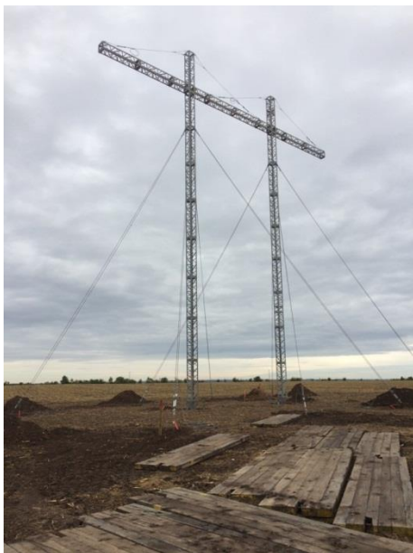
Abb. 10: Provisorischer Mast mit Erdankern für die Aufnahme eines Systems (Quelle: 50Hertz).
