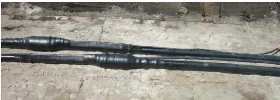
Abbildung 5: Fertige Muffen vor dem Verfüllen mit Bettungsmaterial
