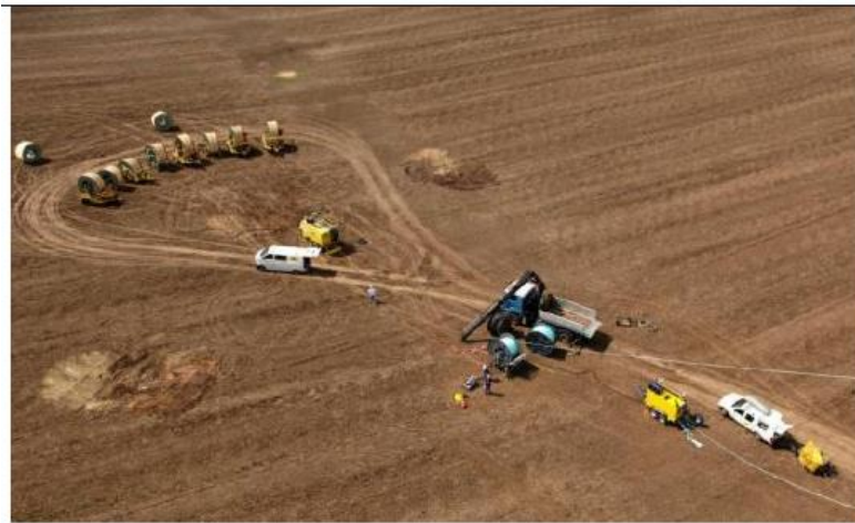
Abbildung 8: Trommel- und Windenplatz für Seilzug bei der Umbeseilung (Quelle: 50Hertz)
