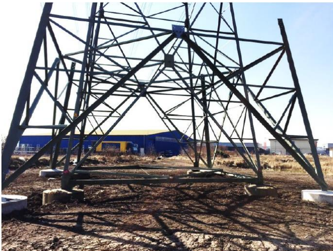
Abbildung 12: Standortgleicher Masttausch: Bestandsmast (innen) umgeben vom neuerrichteten Fundament und Mastfuß (außen) (Quelle: 50Hertz)
