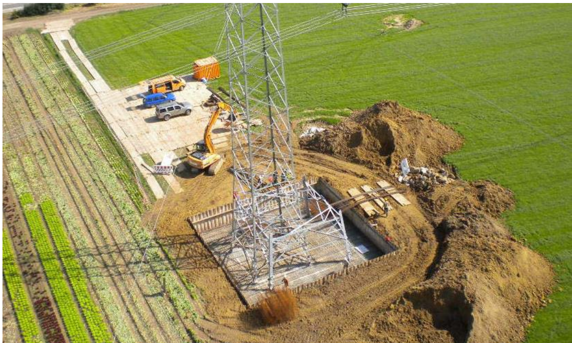
Abbildung 32: Beispiel einer Baustelleneinrichtungsfläche mit Fundamentgrube (standortgleicher Ersatzneubau)
