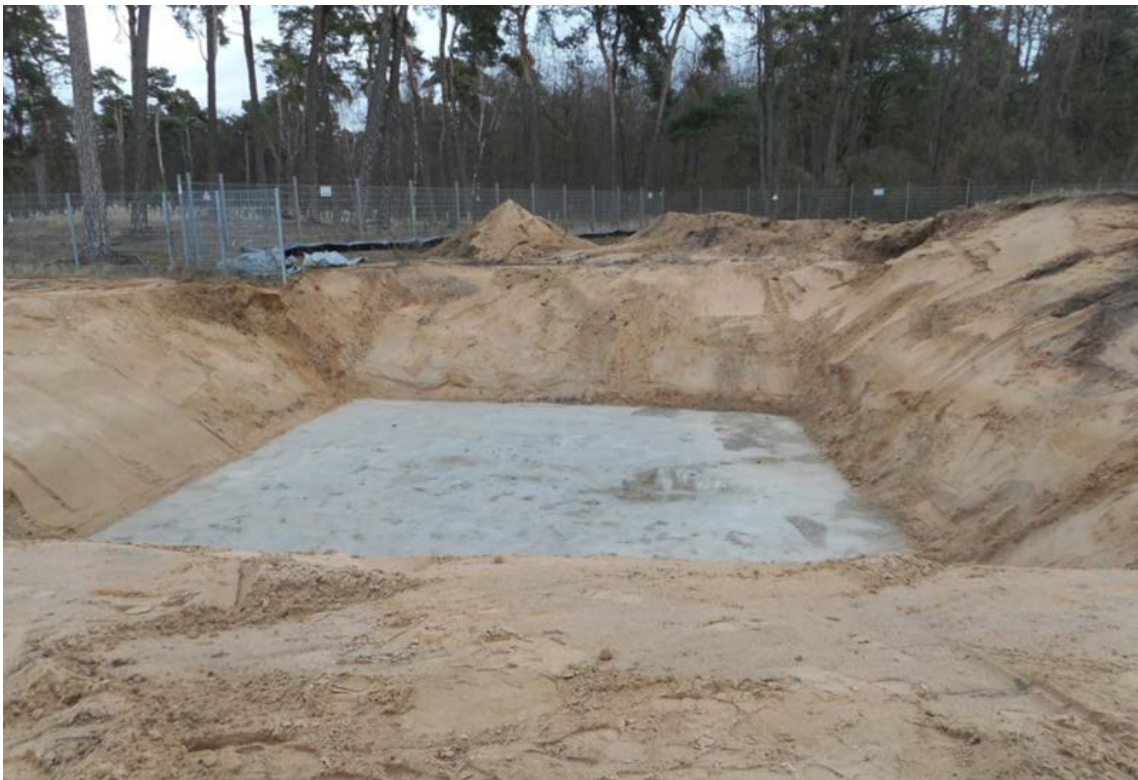
Abbildung 36: Geböschte Baugrube mit eingebrachter Sauberkeitsschicht
