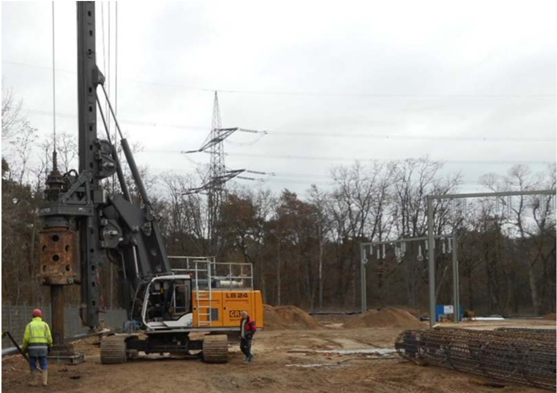
Abbildung 34: Bohrgerät für Bohrpfahlgründung mit liegenden Bewehrungskörben
