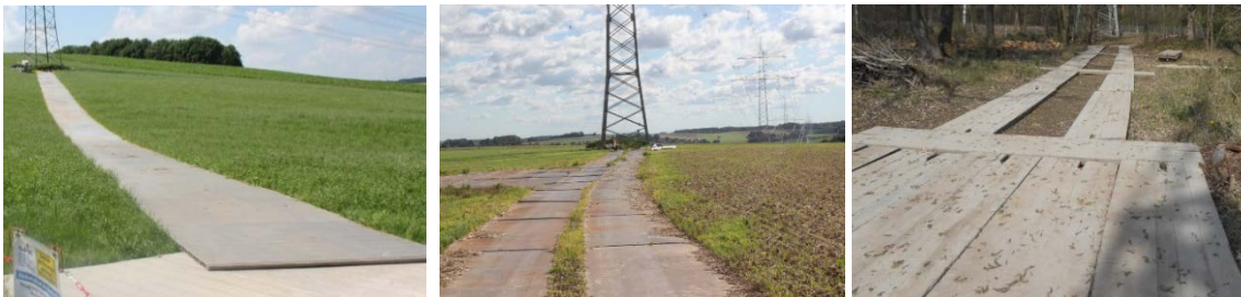
Abbildung 33: Temporäre Zuwegung mit Alu-Panels (links), mit Stahlplatten (Mitte) bzw. mit Baggermatten (Holz) (rechts)
