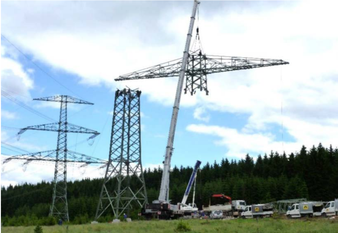
Abbildung 37: Maststocken mit einem Mobilkran
