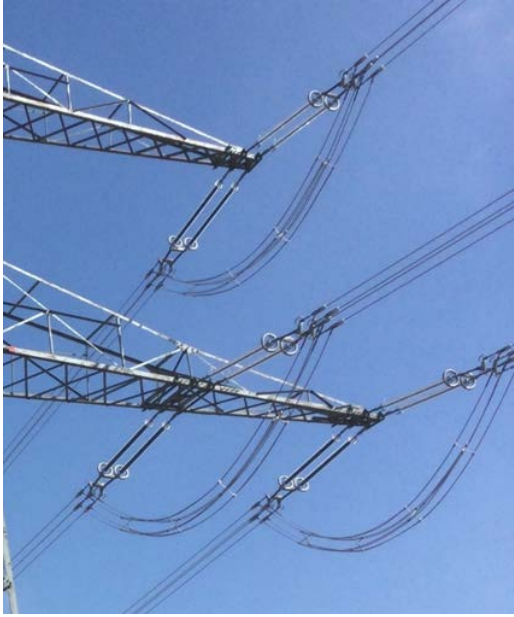
Abbildung 28 380-kV-Doppelabspannkette für 4er-Bündelleiter
