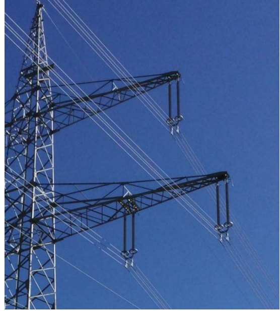
Abbildung 29: 380-kV-Doppelhängekette für 4er-Bündelleiter
