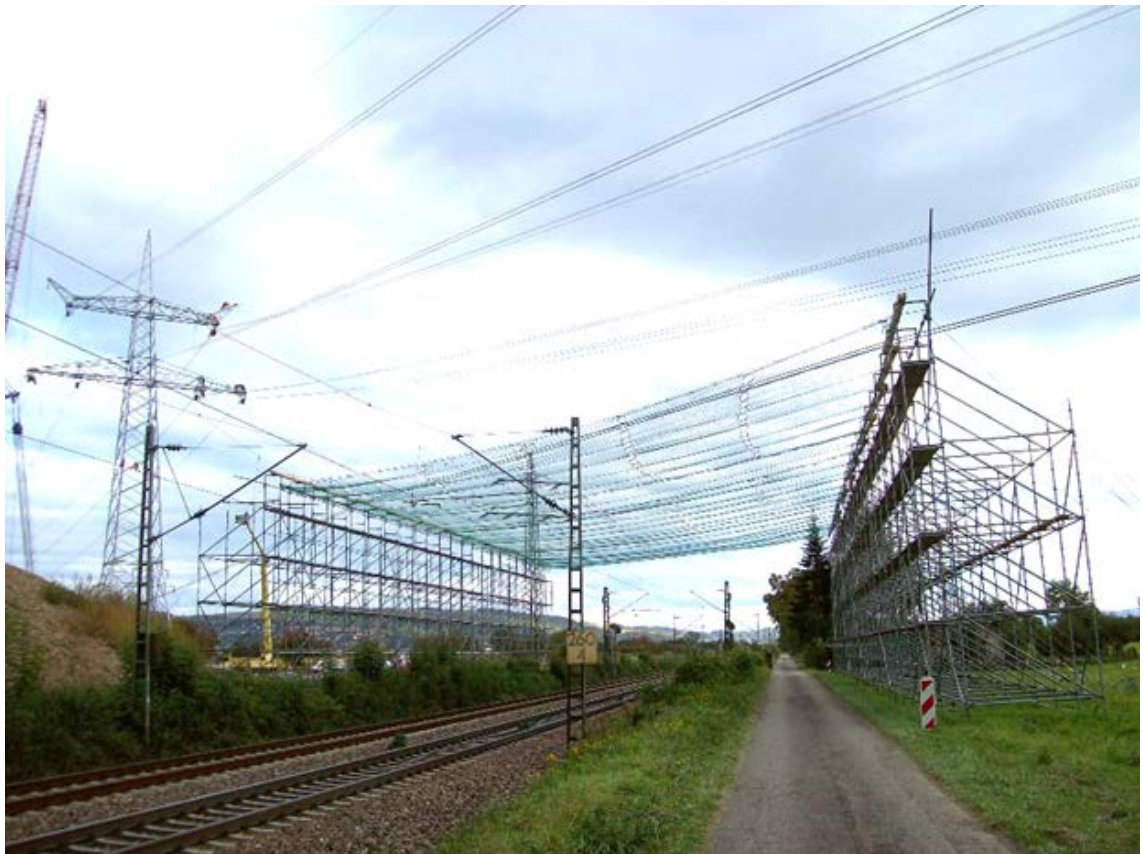
Abbildung 42: Schutzgerüst über Bahntrasse
