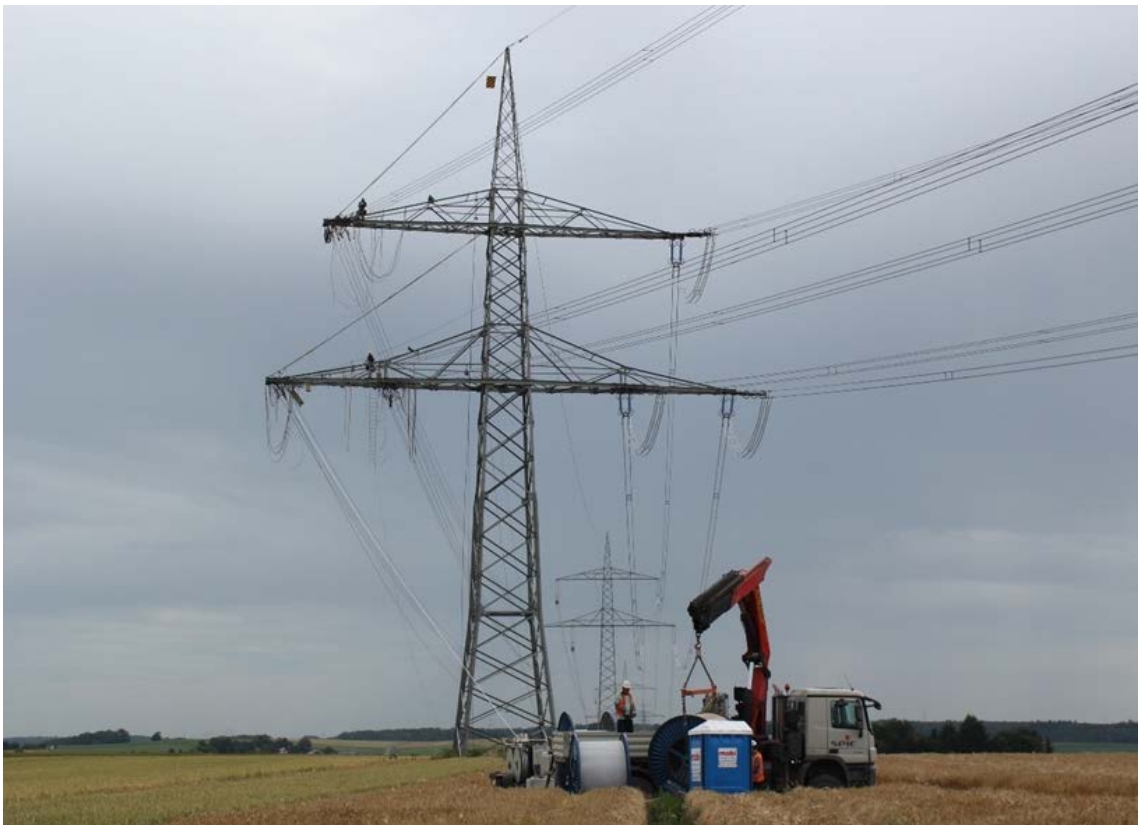
Abbildung 40: Seilzugarbeiten an einem Trommelplatz
