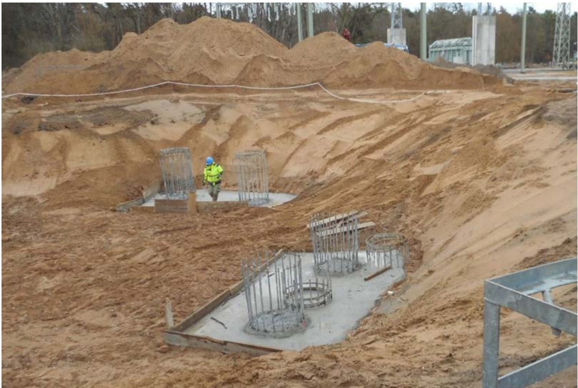
Abbildung 35: Baugrube mit Bohrpfahlgründungen mit eingebrachten Bohrpfählen
