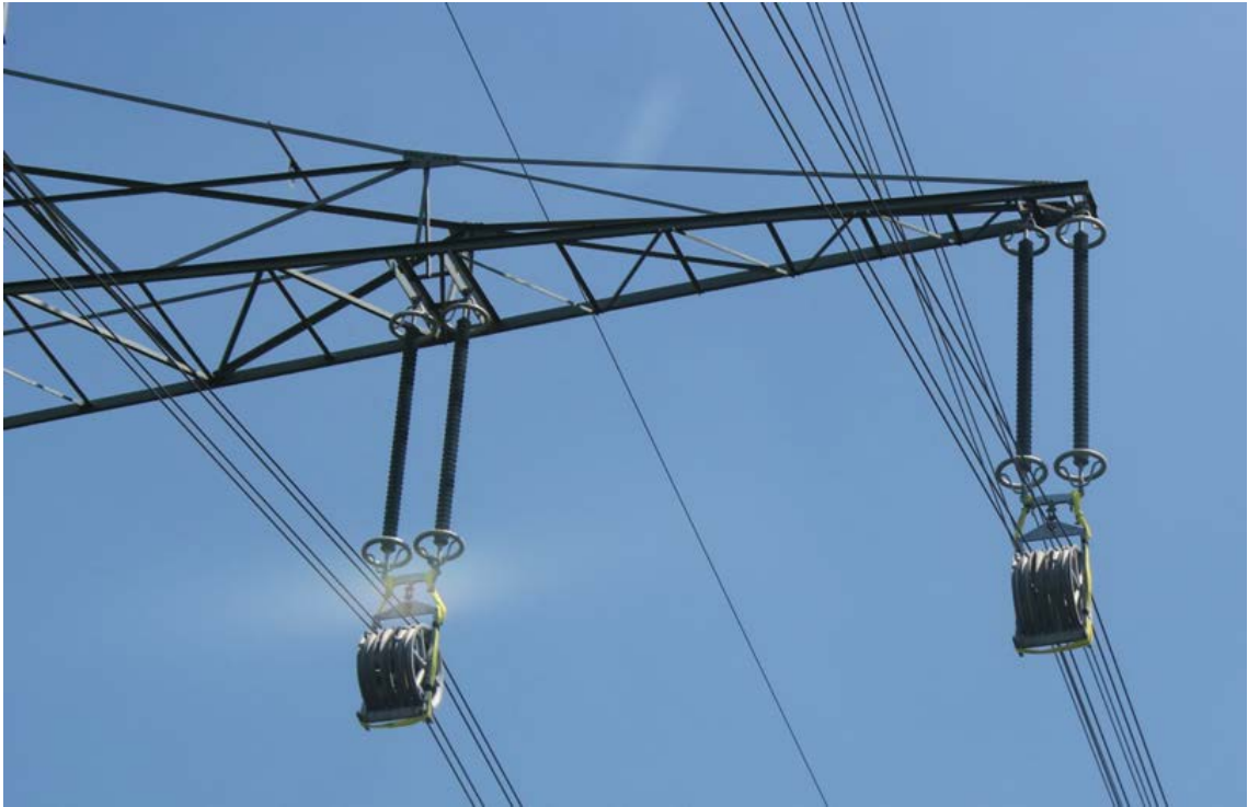
Abbildung 39: Seilrollen an Isolatorketten befestigt
