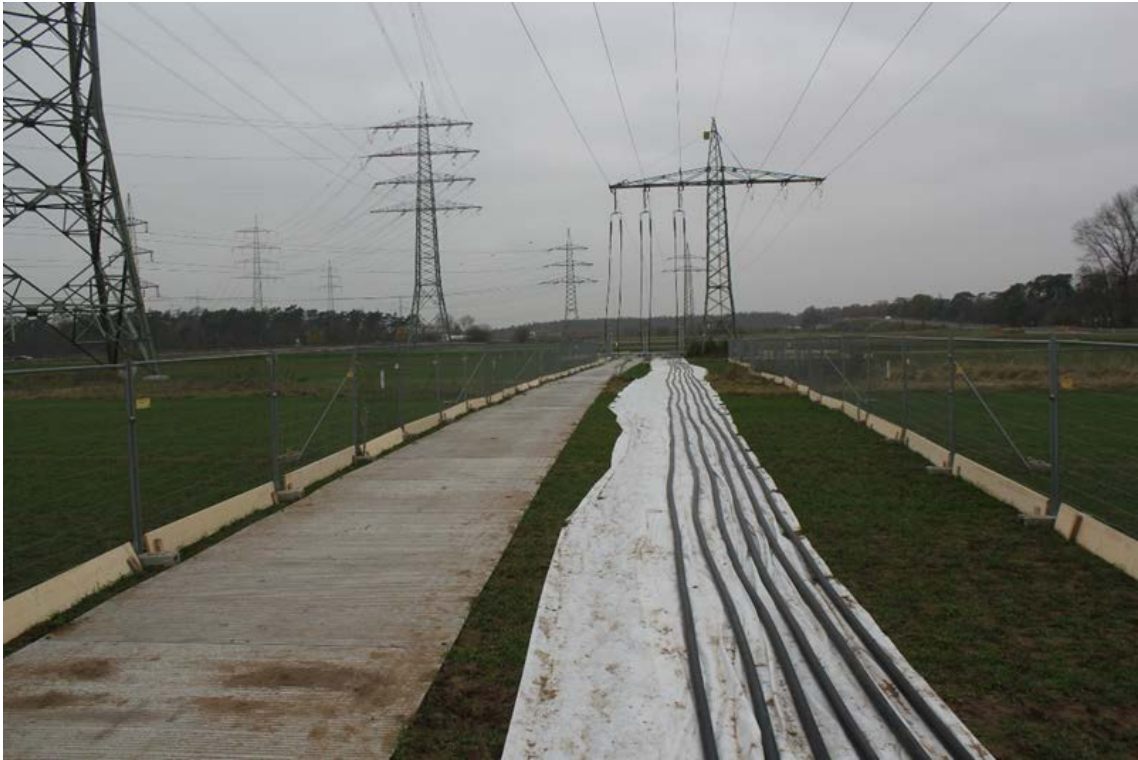
Abbildung 49: Beispiel eines Baueinsatzkabels (110-kV)
