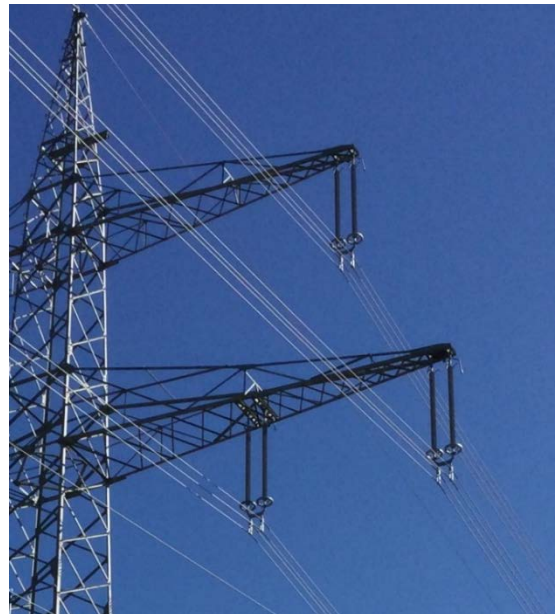
Abbildung 31: 380-kV-Doppelhängekette für 4er-Bündelleiter
