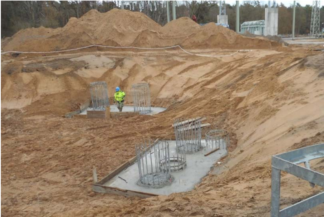
Abbildung 37: Baugrube mit Bohrfahlgründungen mit eingebrachten Bohrpfählen
