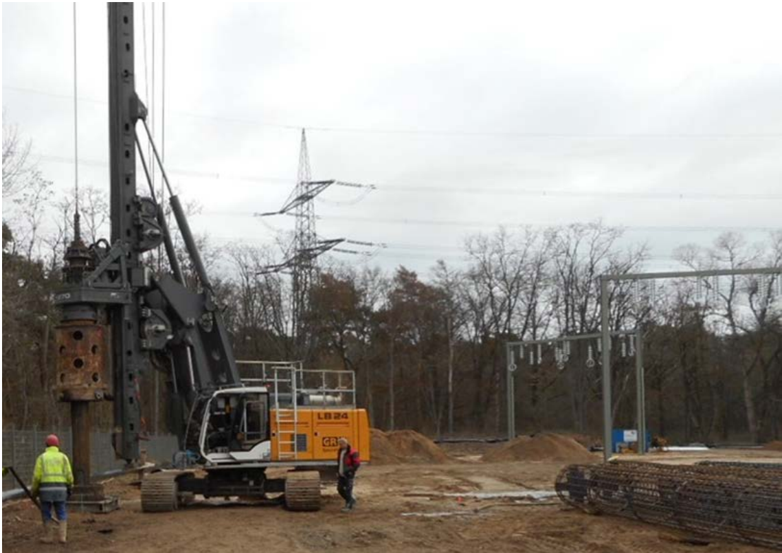
Abbildung 36: Bohrgerät für Bohrpfahlgründung mit liegenden Bewehrungskörben
