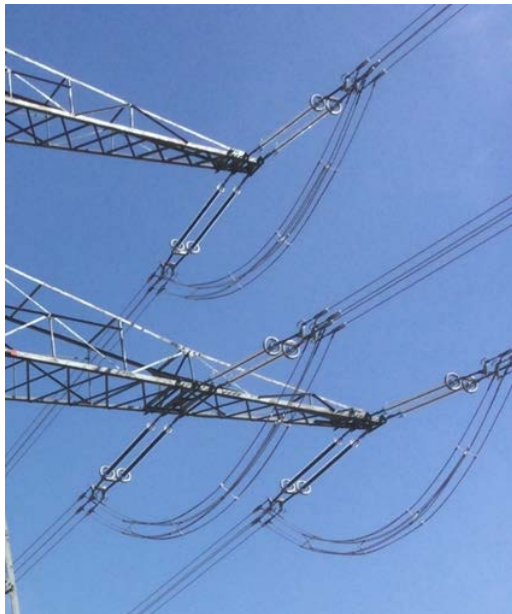
Abbildung 30 380-kV-Doppelabspannkette für 4er-Bündelleiter
