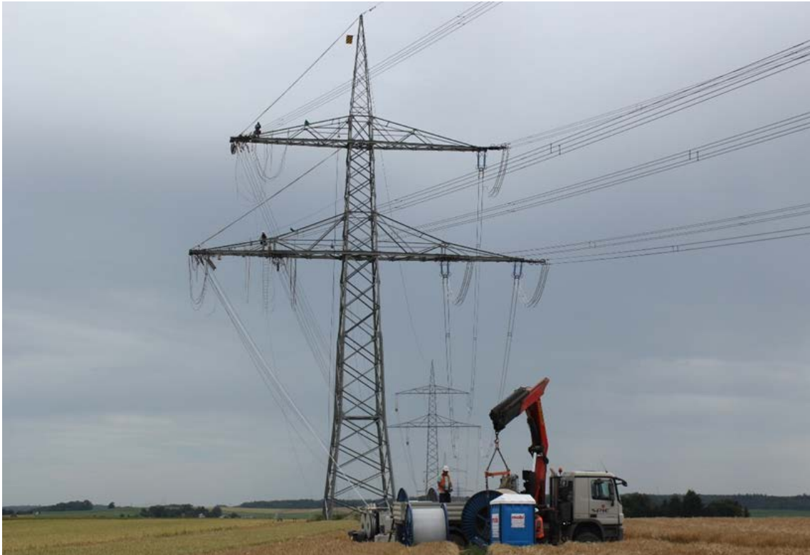
Abbildung 42: Seilzugarbeiten an einem Trommelplatz
