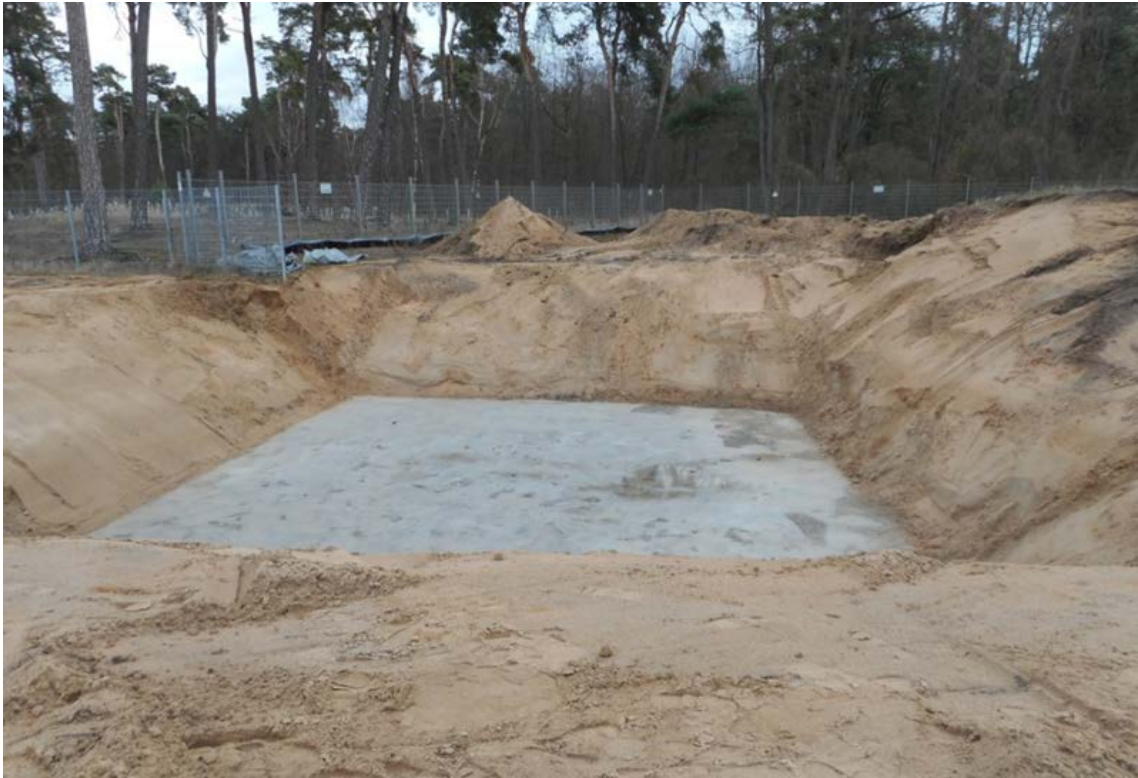
Abbildung 38: Geböschte Baugrube mit eingebrachter Sauberkeitsschicht
