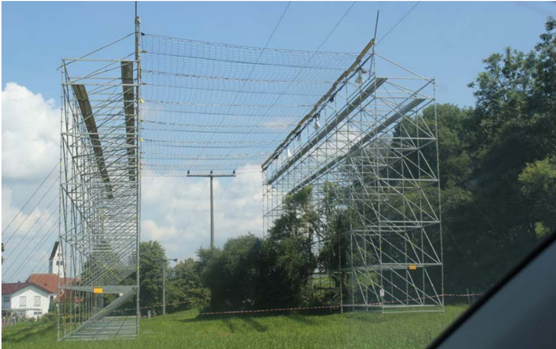
Abbildung 45: Schutzgerüst über Niederspannungsleitung
