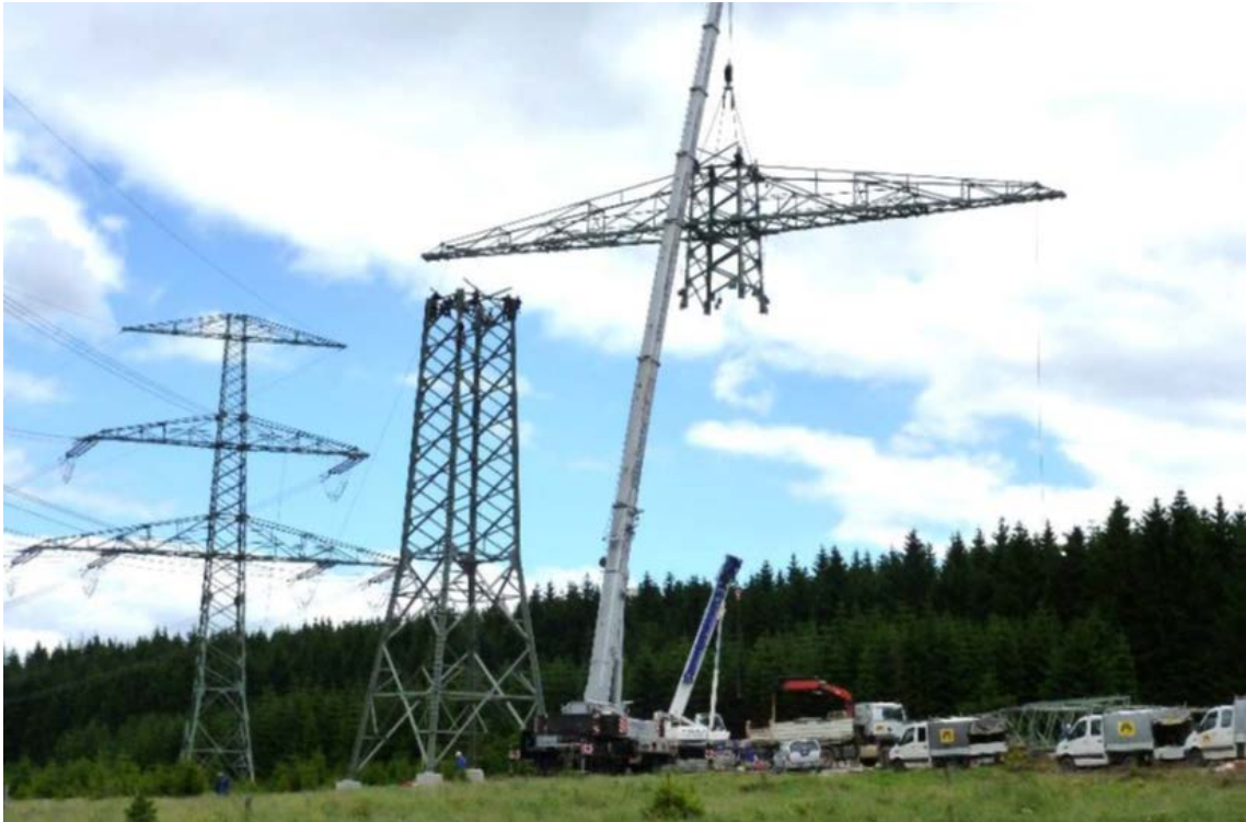
Abbildung 39: Maststocken mit einem Mobilkran
