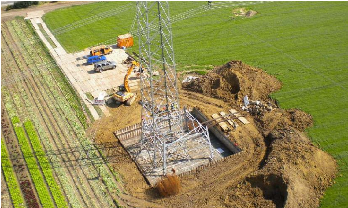
Abbildung 34: Beispiel einer Baustelleneinrichtungsfläche mit Fundamentgrube (standortgleicher Ersatzneubau)
