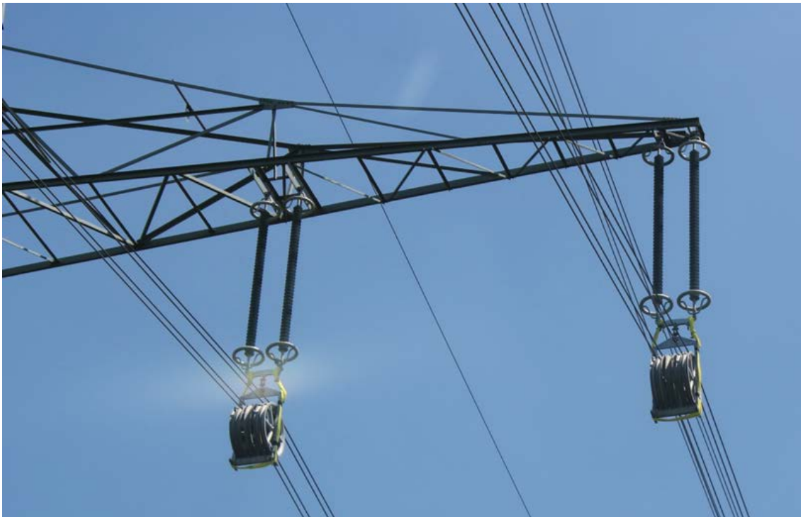
Abbildung 41: Seilrollen an Isolator Ketten befestigt
