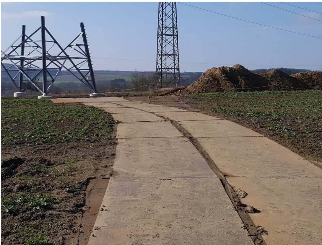
Abbildung 7: Temporäre Zuwegung über Fahrplatten
