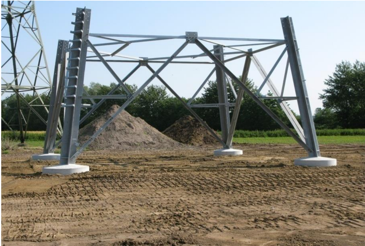
Abbildung 12: Montierter Mastfuß
