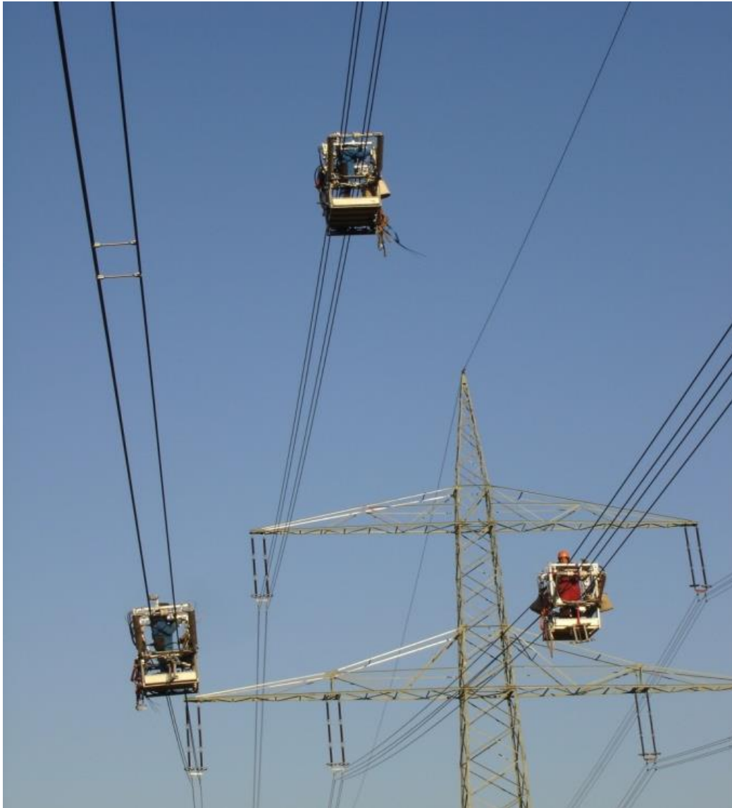
Abbildung 17: Montage der Feldbündelabstandhalter mit Fahrwagen
