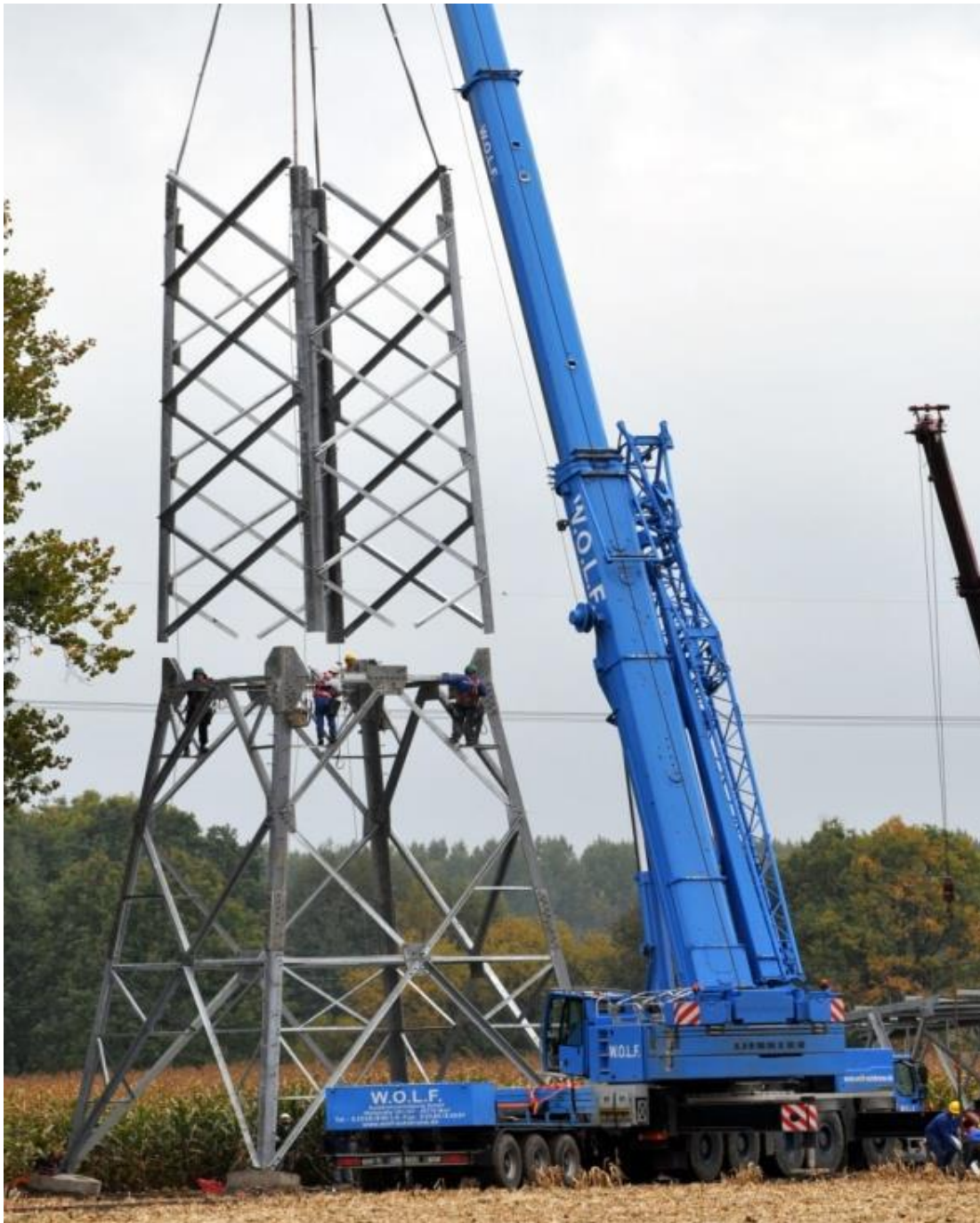
Abbildung 13: Mastmontage (Stocken)
