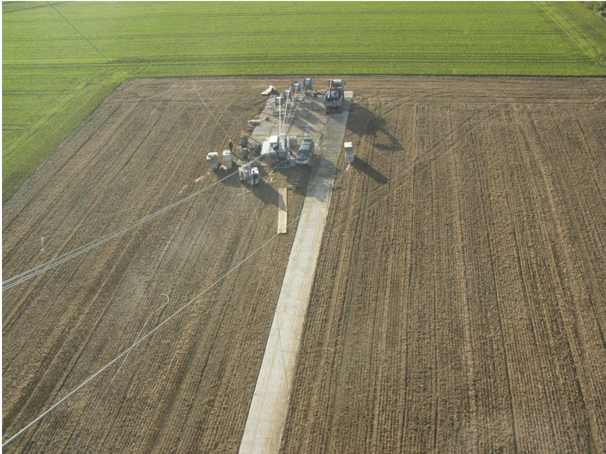
Abbildung 16: Windenplatz eines Viererbündel-Seilzuges
