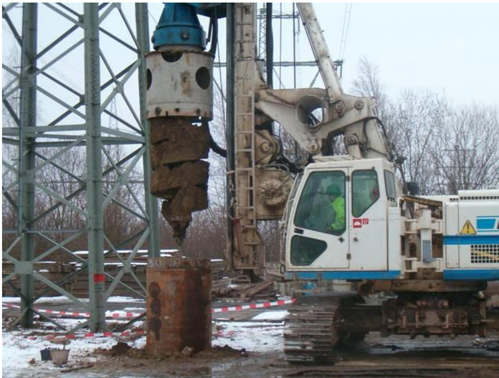
Abbildung 11: Bohrung für einen Bohrfahl
