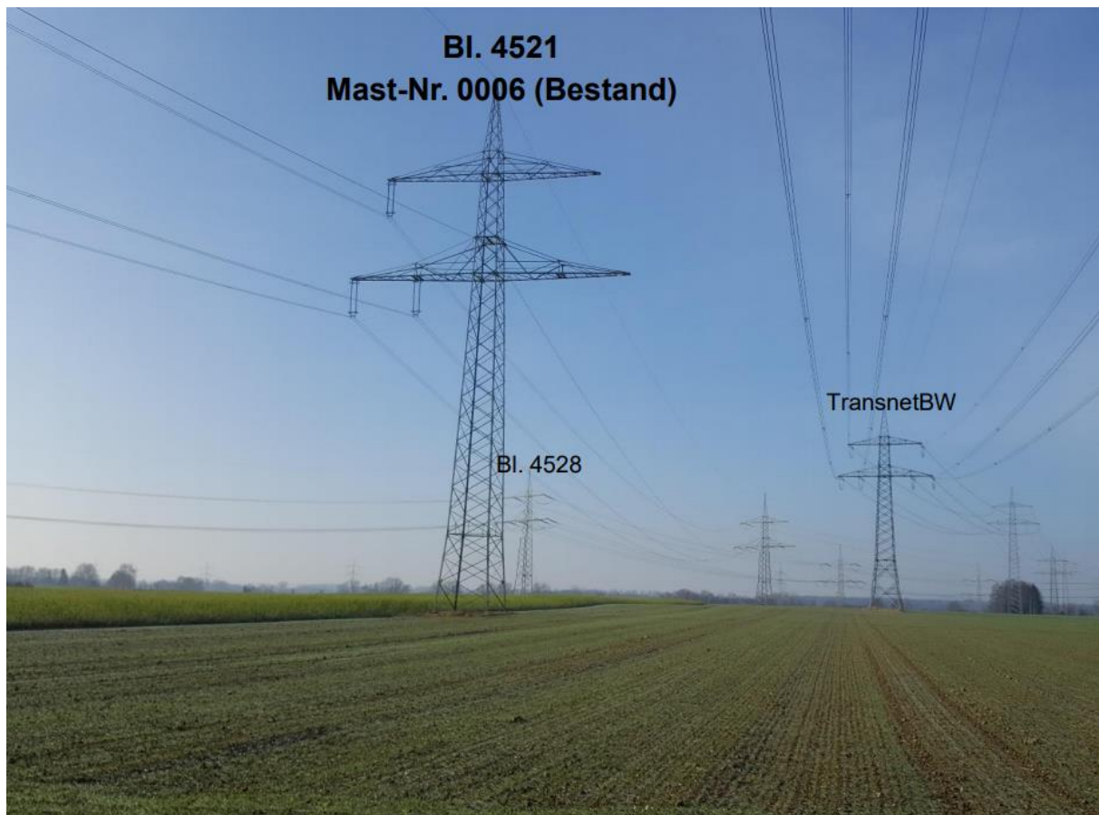
Abbildung 3: Bestandssituation Bl. 4521 (Mast-Nr. 0006 – Masttyp D1)
